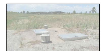
TYPICAL VAULT HATCH & VENTILATION
