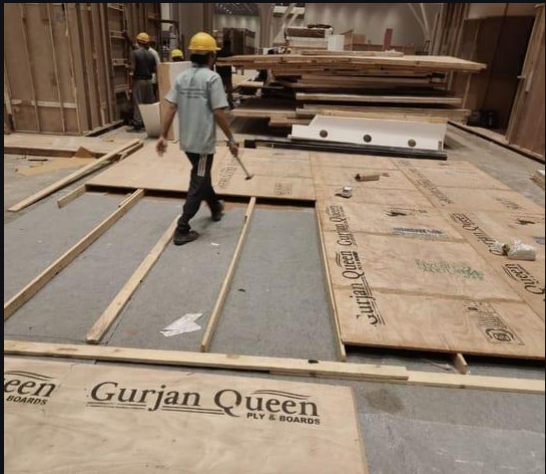
vi · panel install
