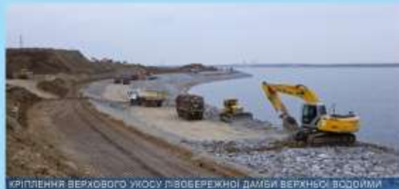
КРІПЛЕННЯ ВЕРХОВОГО УКОСУ РІВБЕРЕЖНОЇ ДАМБИ ВЕРХНЬОЇ ВОДОЙМИ
