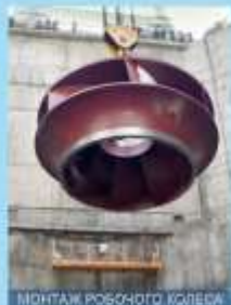
МОНТАЖ РОБОЧОГО КОЛЕСА
