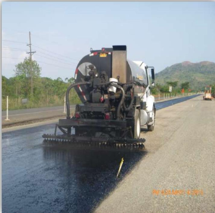
Es un equipo que se utiliza en la aplicación de tratamientos superficiales, en la imprimación de capas base antes de colocar la carpeta asfáltica
