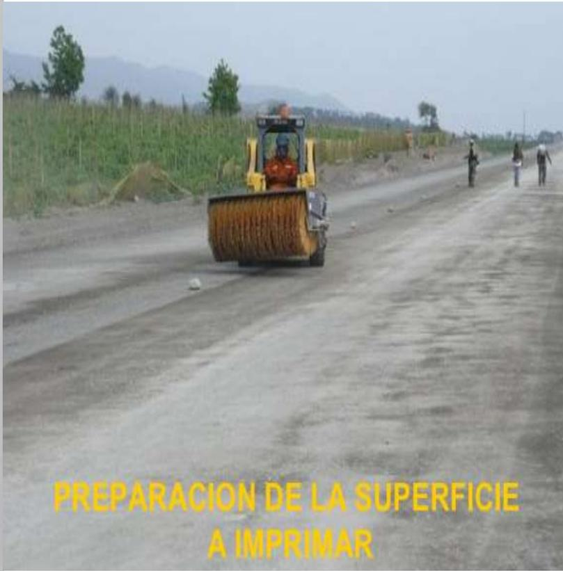
Previo a la aplicación de un riego de imprimación o de adherencia, es imprescindible limpiar perfectamente la superficie que va a recibirlo de partículas sueltas, polvo, barro seco o cualquier material que perjudique la perfecta unión con la capa de aglomerado.
