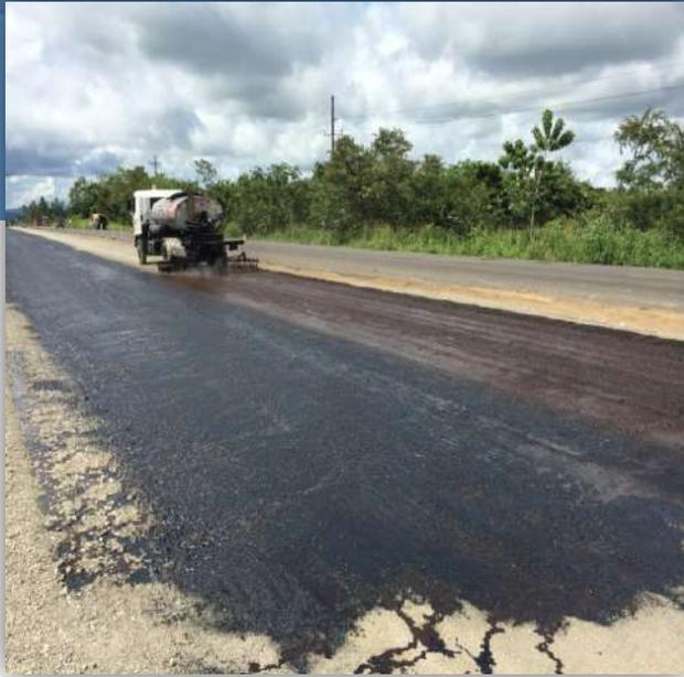
Este equipo cumple las tareas de imprimación, riego de emulsión asfáltica y está diseñado para bombear y pulverizar los distintos productos asfálticos.
