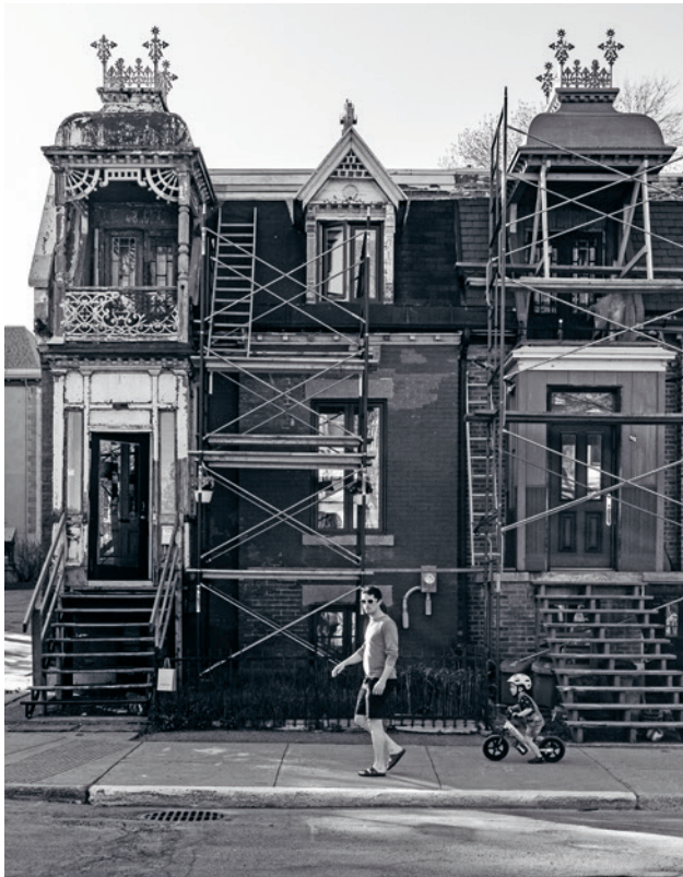
▲ PHOTO CONTEMPORAINE Rue Coursol au coin de la rue Dominion, une des plus vieilles maisons du Quartier de l’innovation voit sa façade d’origine restaurée, contribuant à la richesse du patrimoine architectural du territoire.
