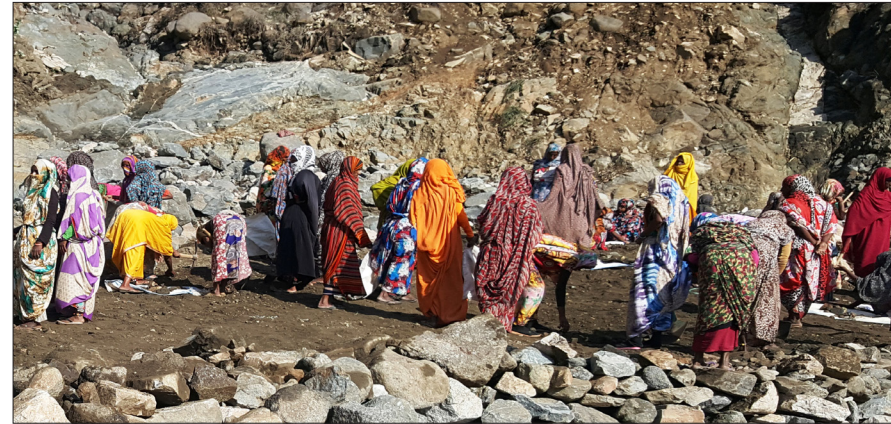
ደቀንስትዮ ናቕፋ ኣብ ምዝርጋሕ መስመር ማይ
