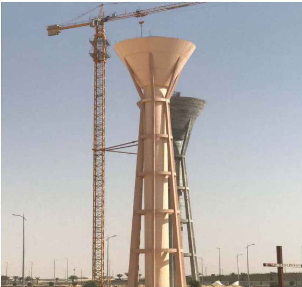
إنشاء خزانات مياه علوية بمشروع مجمع الدوائر الحكومية بالرياض
