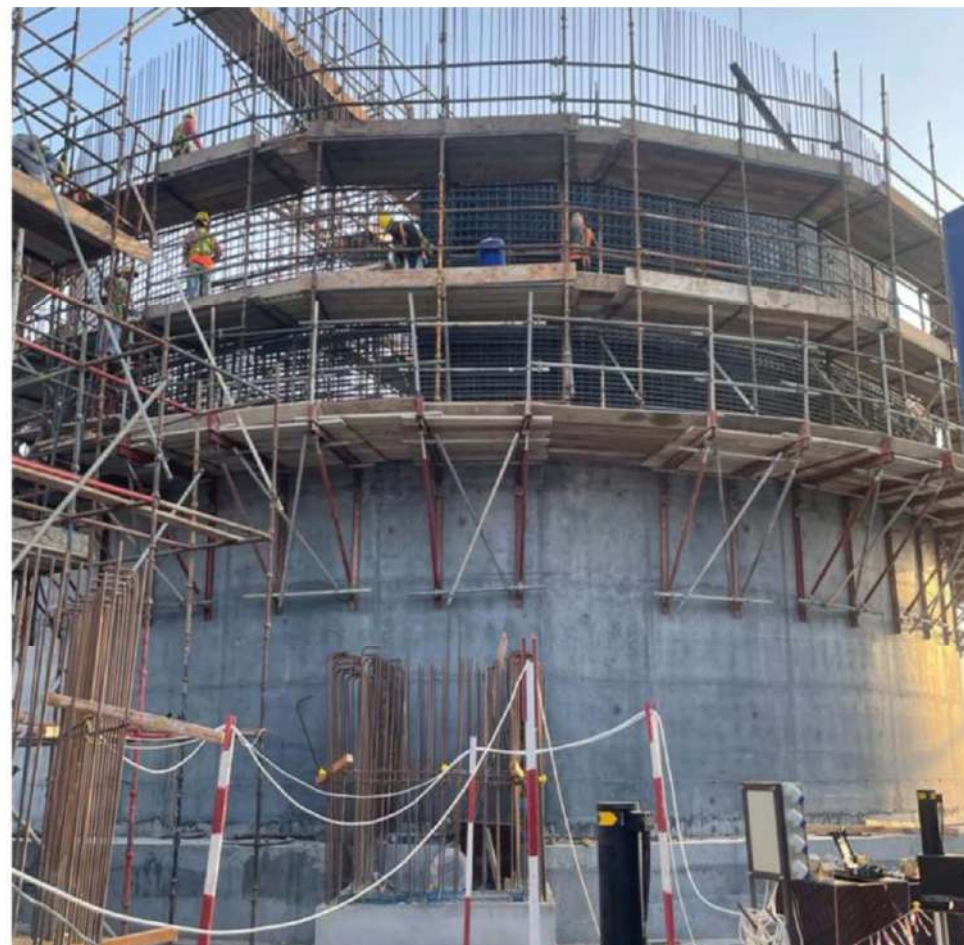
إنشاء خزانات الصرف الصحي في الدمام طريق المطار
