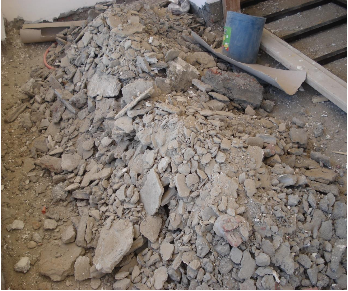
1-تجهيز موقع الاعمال للبدء في تركيب الباركيه المسمار.
