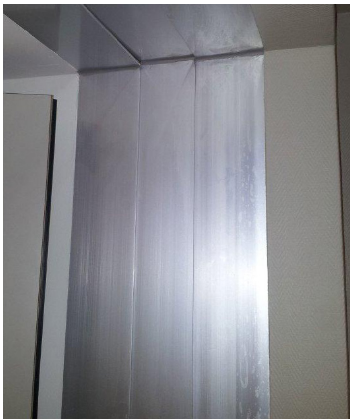
JDV 4.02 - Hospital de Grasse -FRANCIA
