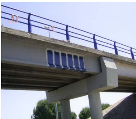
Refuerzo a cortante en vigas.
