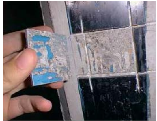
Un mal tratamiento del soporte y la oclusión de burbujas de aire, provocan mala adherencia. Una mala adherencia provoca el fallo del refuerzo.
