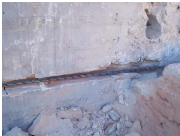
Inserción de la barra MasterBrace BAR en una roza ejecutada previamente en el elemento de hormigón a reforzar
