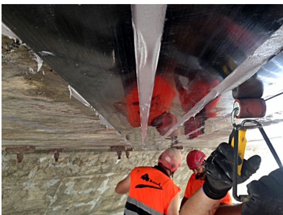
Presión y eliminación de adhesivo sobrante.
