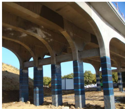
Refuerzo mediante confinamiento de pilares y capiteles
