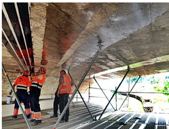
Adhesión al paramento de MasterBrace LAM con adhesivo. El soporte se encuentra previamente imprimado y con una capa de Adhesivo.
