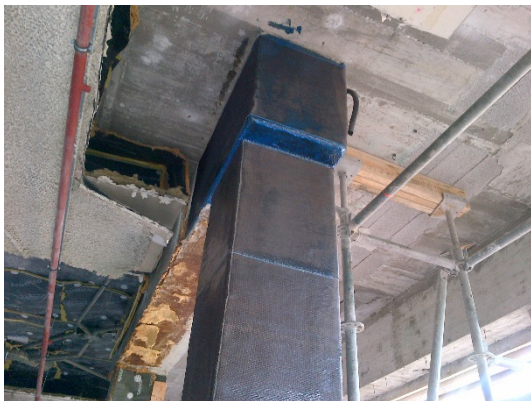
Ejemplo de refuerzo de pilares con aristas redondeadas mediante hoja MasterBrace FIB
