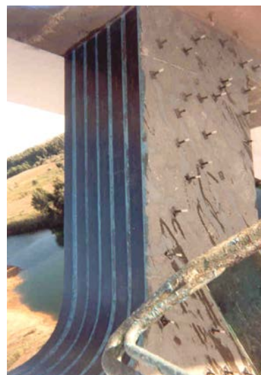
Inyección y refuerzo externo con MasterBrace LAM. El refuerzo controla la nueva aparición de fisuras debido a las cargas
