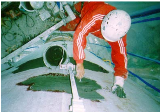
Reparación estructural con MasterEmaco S 5400 y puente de unión epoxi MasterEmaco P 2000 BP
