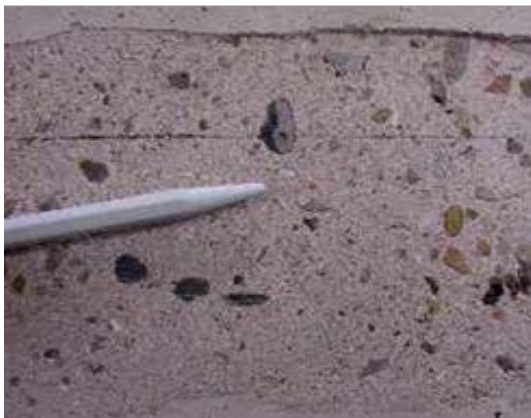
Es requisito indispensable en los refuerzos adheridos un buen tratamiento del soporte.
