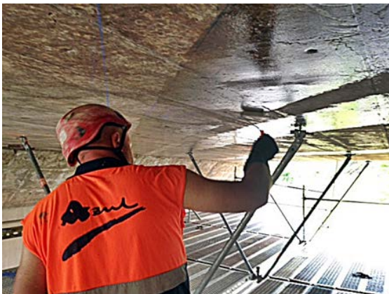
Aplicación de la imprimación epoxi mediante rodillo sobre soporte tratado y aspirado (chorreo o similar)
