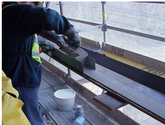
Dispensador de adhesivo a modo de guillotina, con altura libre para paso del espesor de LAM y espesor de adhesivo (inferior a 3 mm).
