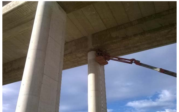
Acabado final anticarbonatación MasterProtect 325 EL
