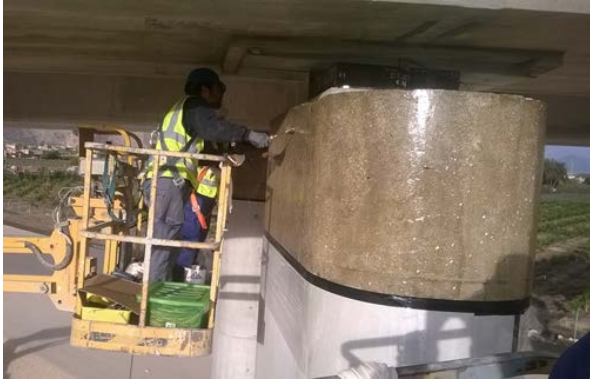
Soporte tratado e imprimado con MasterBrace P 3500
