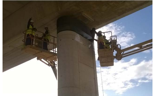
Aplicación de MasterBrace FIB embebido en capa de adhesivo saturante MasterBrace SAT 4500
