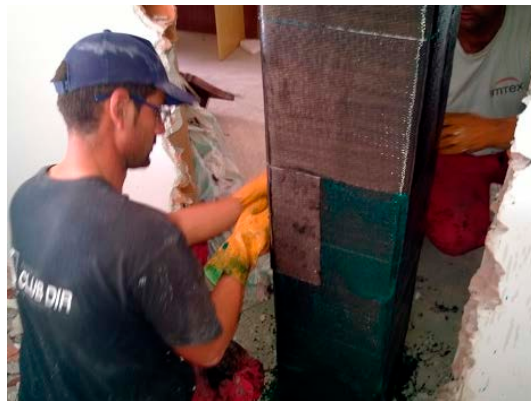
Ejemplo de refuerzo de pilares con aristas redondeadas mediante hoja MasterBrace FIB
