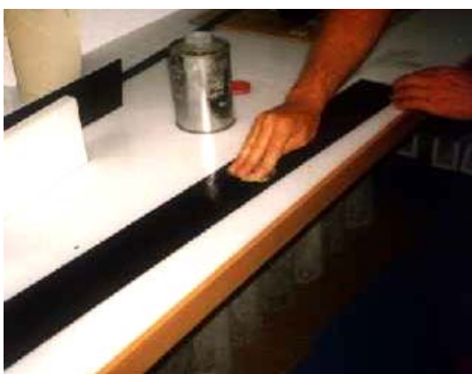
La limpieza del MasterBrace LAM con acetona y algodón es recomendable para una perfecta adherencia.
