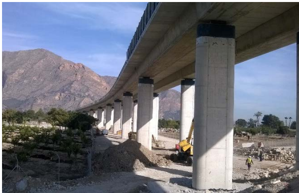
Zunchado superior de pilas con tejido de hoja MasterBrace FIB
