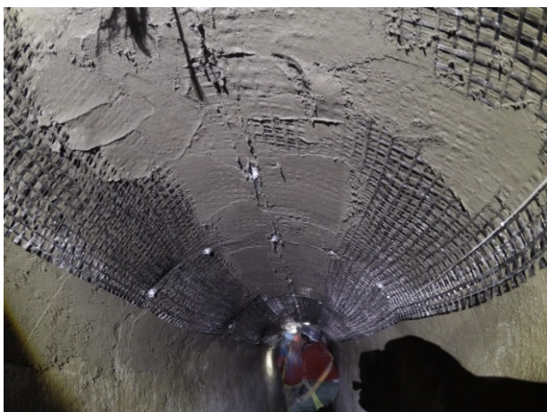
Aplicación MasterBrace NET como refuerzo en una galería de servicios.
