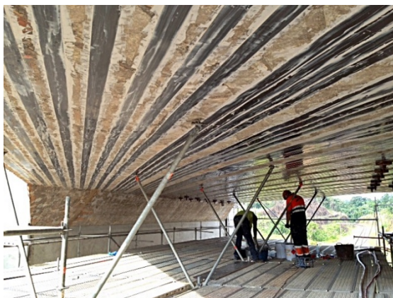
Vista del refuerzo colocado.
