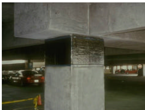
Ilustración 1.- Refuerzo a confinamiento en cabeza de pilares
