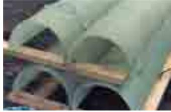
3. Se colocan los separadores, puertos de inyección y remaches
