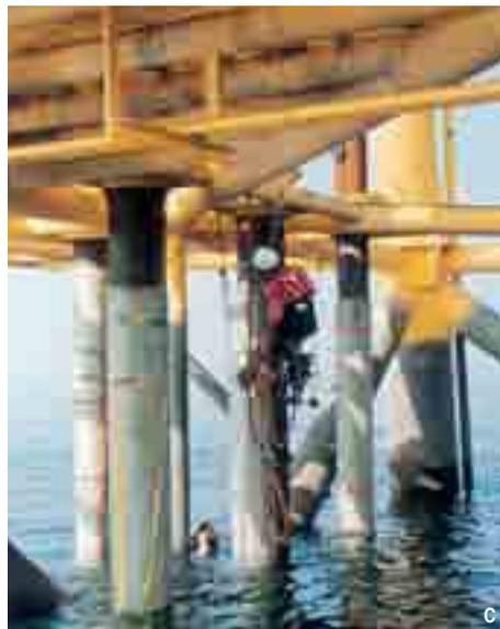
Sobre el agua se completa la instalación de las camisas en tres conductores, los buzos completarán la instalación con una altura de encapsulado de 6 metros por conductor.
