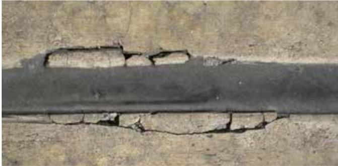
*Note el delaminado de los bordes del concreto adyacentes al sello de junta.*
