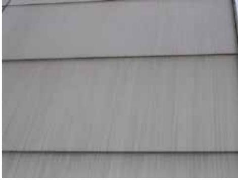
*Fotografía del residuo por escurrimiento de silicón, un sellador de silicón fue aplicado de forma continua entre los paneles. Observe como el escurrimiento deja veteado debajo de la línea horizontal del sello de la junta.*
