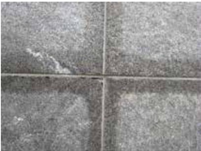
*El desplazamiento de líquido de silicón a los poros de una fachada de piedra.*
