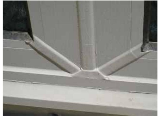
Juntas puente estáticas con recubrimiento de pared sobre el sellador y estructura metálica.
