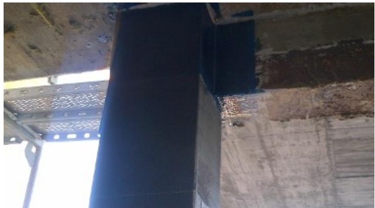
Tal efecto permite reforzar las estructuras de concreto para protección antisísmica, con un aumento significativo de la ductilidad. El confinamiento con FRP puede también emplearse para fijar empalmes en pilares (un problema común en regiones sísmicas donde se requiera empalmes a tracción, pero donde sólo haya empalmes a compresión).
