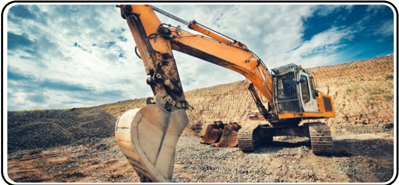
TWEDT CONSTRUCTION (MONTROSE, SD)
