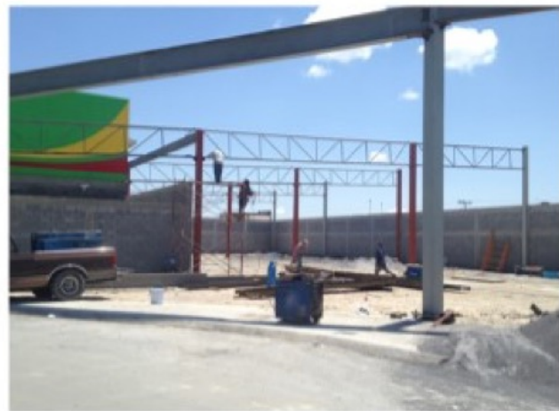
Sum. e inst. de nave industrial Elektra
