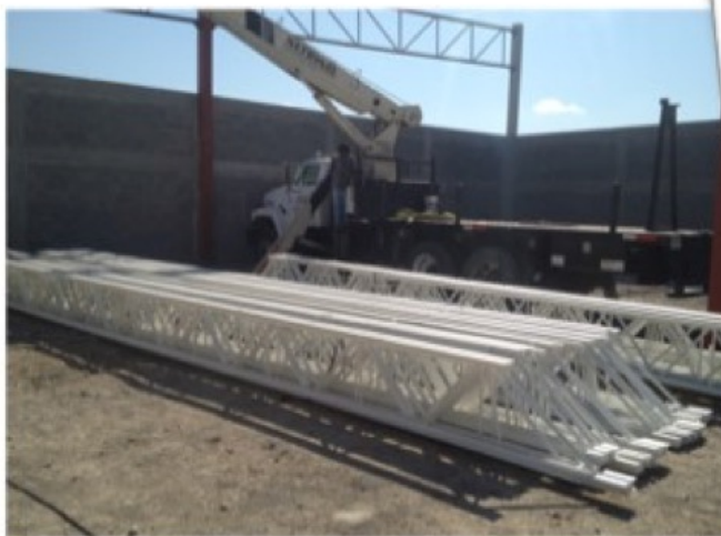
Sum. e inst. de nave industrial Elektra
