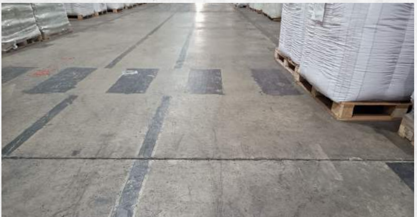
Cargas acidentais - Verticais 1 - Carregamento dos caminhões - 7,5 kN/m 2 .
