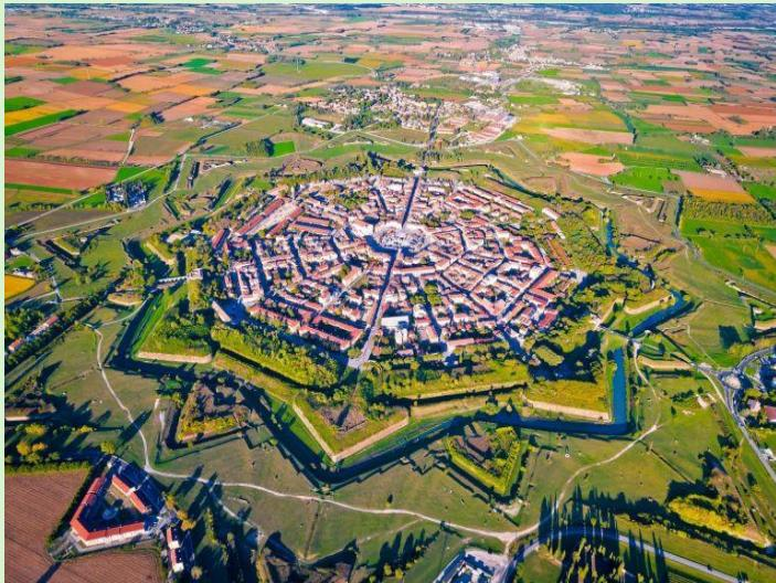
Furono costruite due linee difensive costituite da terrapieni sostenuti da pietre e mattoni. La struttura, progettata e poi realizzata con grande abilità ingegneristica, era costituita da baluardi (o bastioni), cortine murarie, faussebray e rivellini. Tra questi, un fossato e una rete di gallerie sotterranee che consentivano alle truppe di muoversi tra le varie linee.
