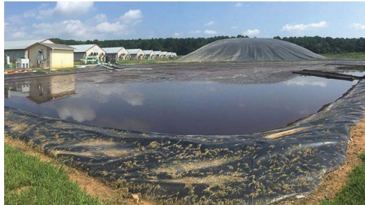
Fig. 67 Digestor de metano cerca de los establos de cerdos en Norte Carolina
