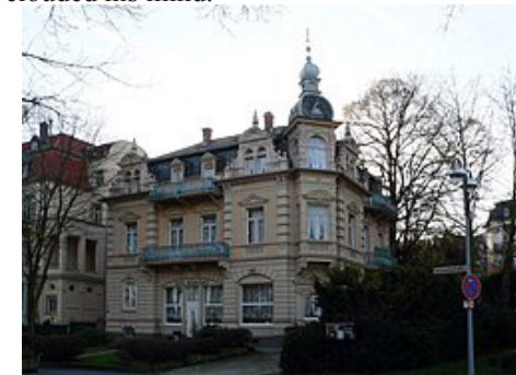
Villa Grunewald, Bad Nauheim
