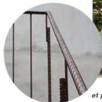
Le garde corps en fer à béton est économique et permet de réutiliser les matériaux de construction.
