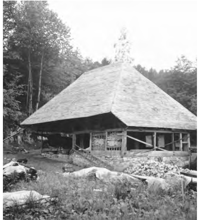
33 Freilichtmuseum der Schweiz, Taunerhaus aus Detligen: Das Taunerhaus während des Wiederaufbaus mit dem bereits wiederhergestellten Schindeldach. Die Wandfüllungen fehlen noch. Deutlich zu erkennen ist die Waldnähe auf der Rückseite, die bis heute besteht. Blick nach Südwesten. Aufnahme um 1968.
