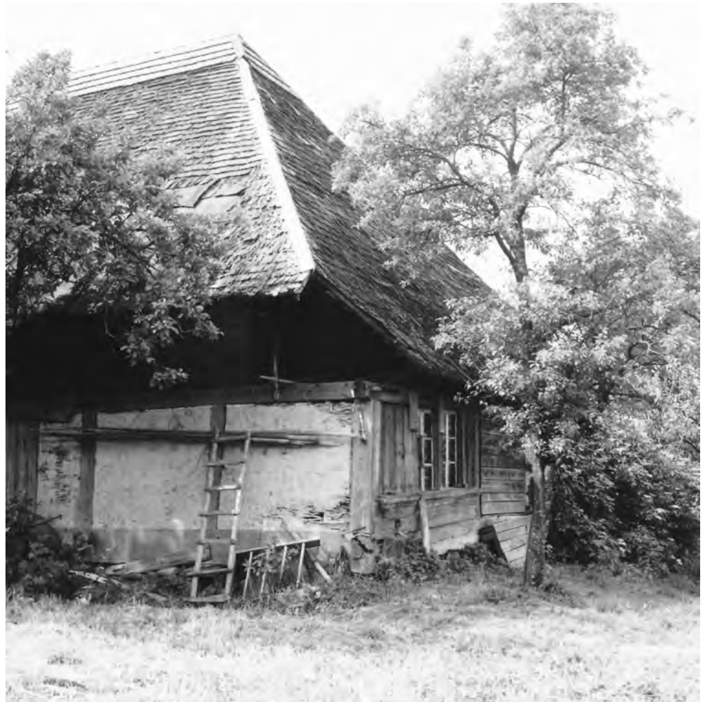
12 Detligen, Untere Schmiede: Nordwestecke des Taunerhauses mit dem Stübli neben der Rauchküche. Deutlich zu sehen ist die mit Flechtwerk ausgefachte Riegelwand, die im Westen zusätzlich eine Holzschalung mit Moos- und Grasisolierung zeigt. Blick nach Südosten. Aufnahme 1965.
