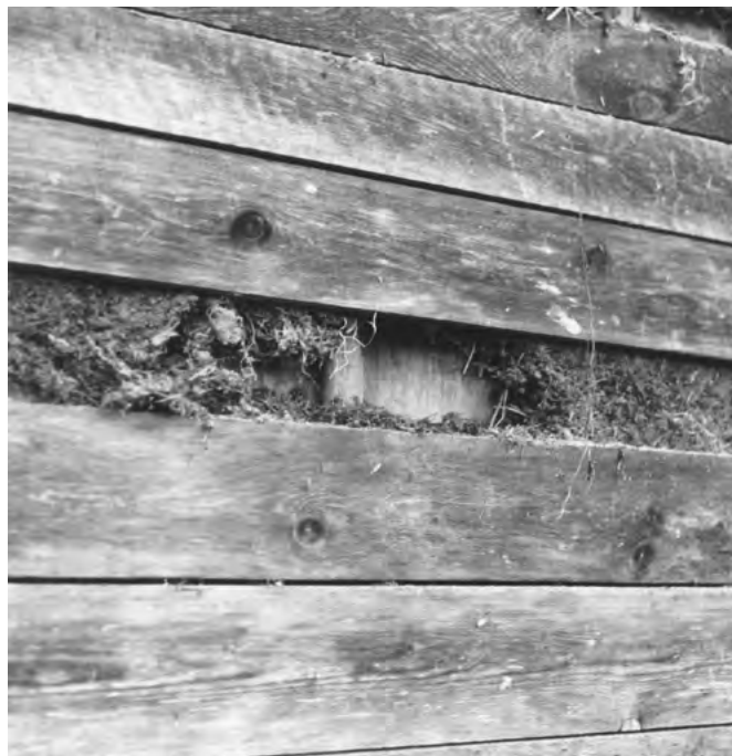
23 Detligen, Untere Schmiede: Detail der Bretterverschalung auf der Nordwestseite des Taunerhauses mit der darunter sichtbaren Isolierung aus Moos und Gras. Aufnahme 1965.
