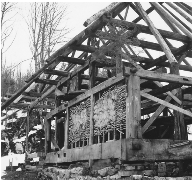
27 Freilichtmuseum der Schweiz, Taunerhaus aus Detligen: Das Hochständengerüst des Taunerhauses während des Wiederaufbaus mit dem darunter eingebauten Wohnteil, der auf einem gemauerten Steinsockel ruht und mit Flechtwerkwänden ausgestattet ist. Die Flechtwände im Erdgeschoss wurden wieder neu in Anlehnung an den alten Bestand eingebaut. Blick nach Südwesten. Aufnahme um 1968.
