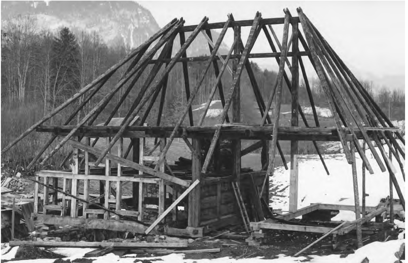
26 Freilichtmuseum der Schweiz, Taunerhaus aus Detligen: Das Hochständengerüst des Taunerhauses während des Wiederaufbaus. Gut zu erkennen ist die Konstruktion des Hochstudbaus. Im Vordergrund befindet sich der Ökonomieteil, im Hintergrund links der Wohnteil. Blick nach Südwesten. Aufnahme um 1968.
