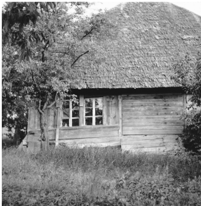
22 Detligen, Untere Schmiede: Nordwestfassade des Taunerhauses. Das Doppelfenster gehört zu dem dahinter angeordneten «Stübli» neben der Rauchküche. Die Fachwerkwand ist mit einer neuzeitlichen Bretterverschalung verkleidet. Blick nach Osten. Aufnahme 1965.
