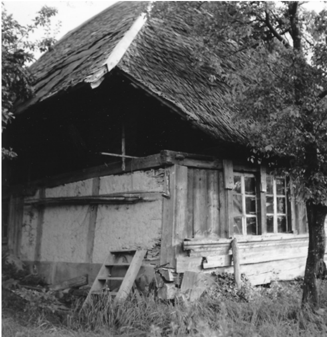
19 Detligen, Untere Schmiede: Nordwestecke des Wohnteils des Taunerhauses. Der Wohnteil ist nur eingeschossig gebaut. Im Obergeschoss springt die Wand unter dem Walmdach bis auf Höhe des Rähmbalkens des jüngeren Hochstudbaus zurück. Blick nach Südosten. Aufnahme 1965.
