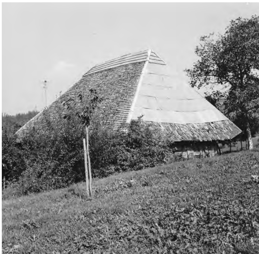
8 Detligen, Untere Schmiede: Die Rückfassade des Taunerhauses mit dem Stallteil verbirgt sich unter dem mit Holzschindeln und Blech gedeckten Vollwalmdach. Blick nach Nordwesten. Aufnahme 1965.
