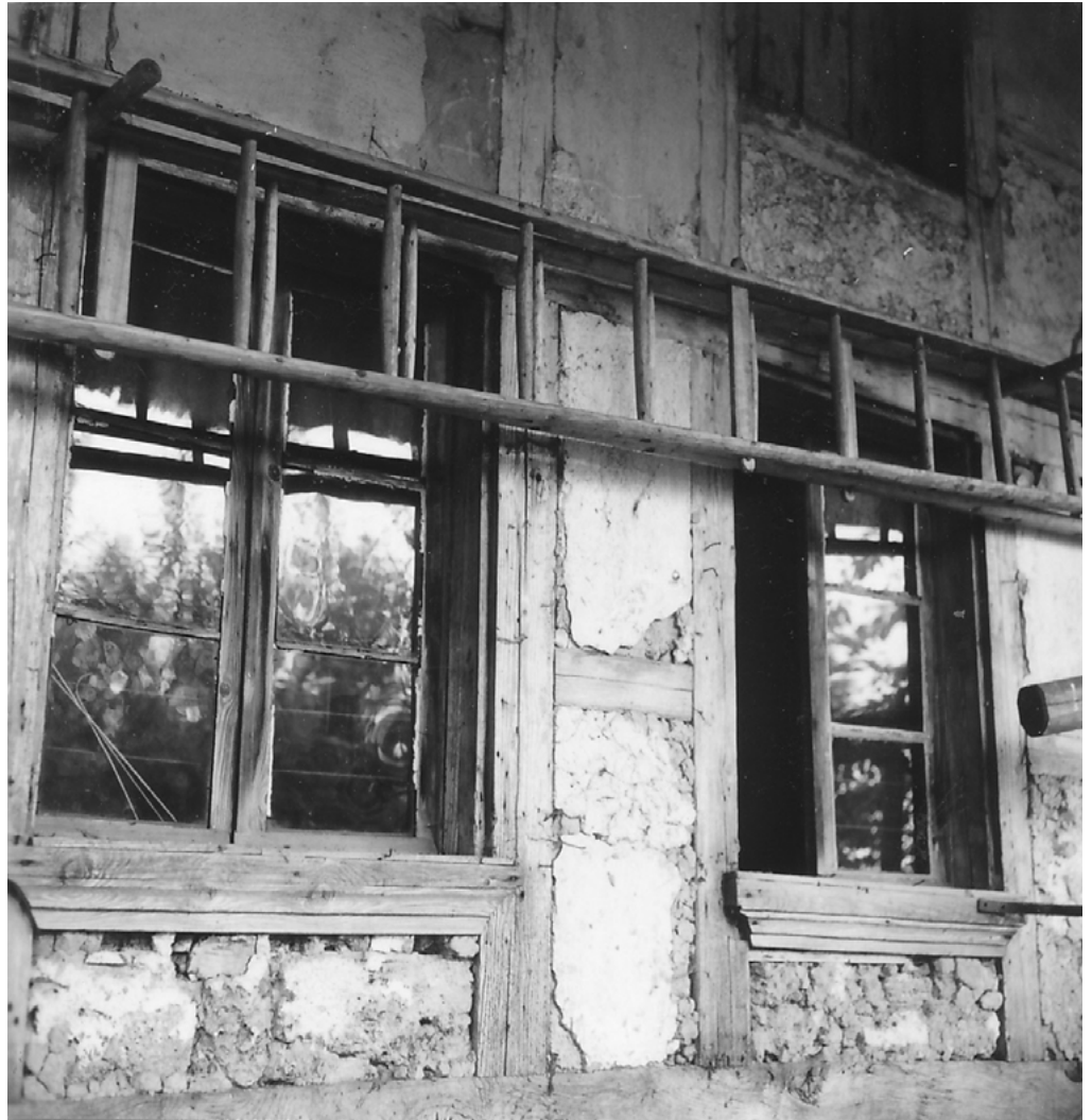
10 Detligen, Untere Schmiede: Südliche Hofseite mit den grossen Einzelfenstern der Stube, die im 19. Jahrhundert zusammen mit der Fachwerkkonstruktion eingebaut worden sind. Blick nach Nordosten. Aufnahme 1965.
