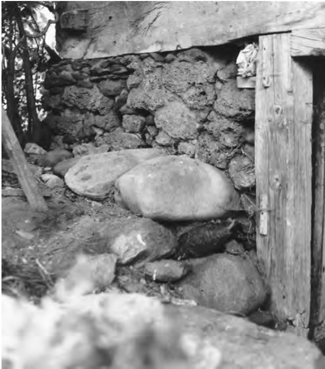
30 Detligen, Untere Schmiede: Gemauerter Sockel des Wohnteils, der hier an der Südwestecke des Taunerhauses zugleich den oberen Abschnitt des Kellers bildete. Am rechten Bildrand ist der Türpfosten des Kellerzugangs zu sehen. Blick nach Nordwesten. Aufnahme 1965.
