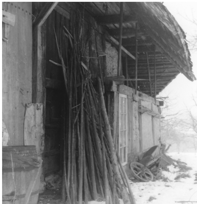
18 Dettligen, Untere Schmiede: Blick entlang der nördlichen Traufseite des Taunerhauses. Im Vordergrund ist hinter den Holzstämmchen das Tenntor zu sehen. Dahinter sieht man den gegenüber der Fassade des Hochstufbaus vorspringenden Wohnteil. Dieser zeigt Fachwerkwände und grosse Einzelfenster im Küchenbereich neben der Haustür, die verdeckt ist. Blick nach Westen. Aufnahme 1965.
