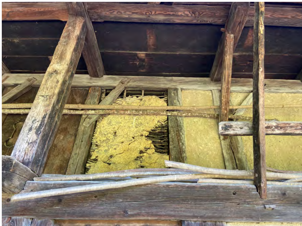
21 Freilichtmuseum der Schweiz, Taunerhaus aus Dettligen: Blick auf die heutige Ostseite des Taunerhauses und die dort rekonstruierte Fachwerkwand mit Flechtwerk und Lehmewurf im Obergeschoss des Wohnteils. Die teils aus translozierten Flechtwerkresten rekonstruierte Wand verläuft zurückgesetzt auf Höhe des Rähmbalkens des Hochstudbaus. Hinter der Wand zieht der Rauch der Küche über das Dach ab. Blick nach Westen. Aufnahme 2022.
