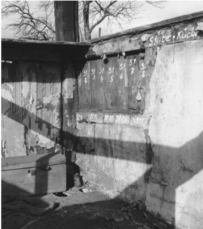
32 Detligen, Untere Schmiede: Küchenbereich des Taunerhauses mit der gemauerten Ofenwand zur Stube und dem Hochstud im Eckbereich. Der Zustand vor der Versetzung verweist auf die lange Nutzungsgeschichte des Gebäudes mit verschiedenen Oberflächen, die immer wieder den Erfordernissen und dem Zeitgeschmack angepasst worden sind. Blick nach Süden. Aufnahme 1965/66.
