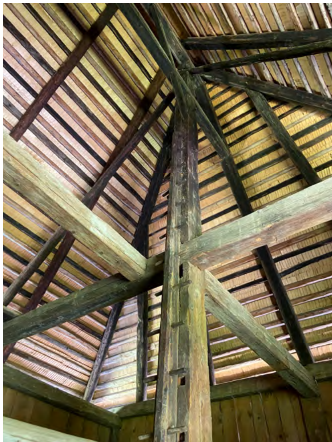
17 Freilichtmuseum der Schweiz, Taunerhaus aus Dettligen: Blick in das Dachwerk des Hochstufbaus im Bereich des Tanns. Noch immer geben sich die russgeschwärtzten Hölzer des ehemaligen Taunerhauses zu erkennen und heben sich von den erneuerten hellen Hölzern des Wiederaufbaus ab. Aufnahme 2022.
