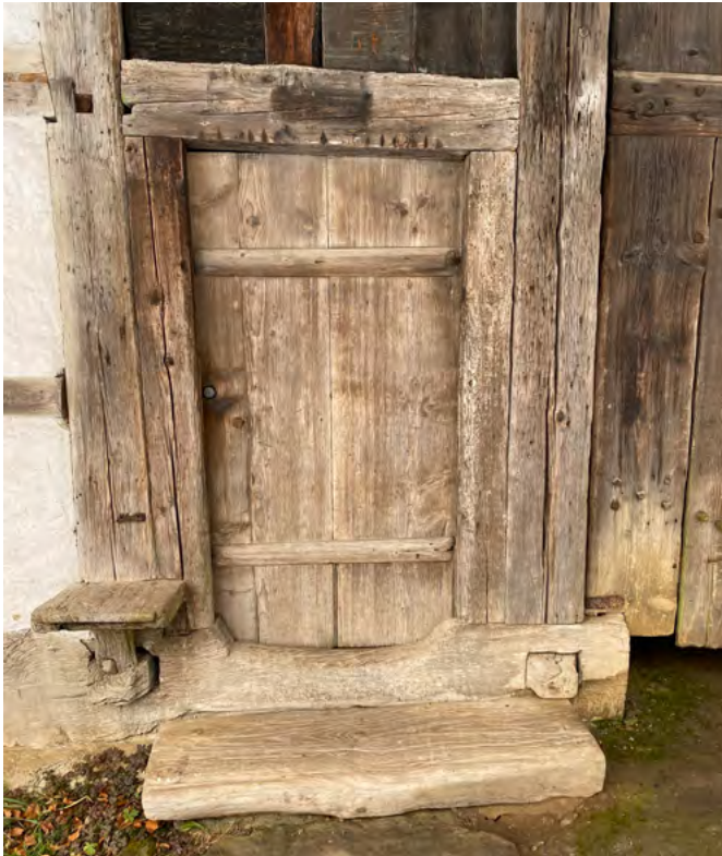
40 Freilichtmuseum der Schweiz, Taunerhaus aus Detligen: Zugangstür auf der ehemaligen südlichen Hof- und Hauptzugangsseite des Taunerhauses. Interessant ist der mit einem kleinen Bug auf dem Schwellenkranz des Wohnteils befestigte Holzsitz neben der Tür. Blick nach Osten. Aufnahme 2021.
