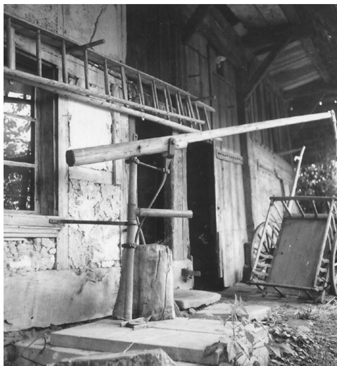
25 Detligen, Untere Schmiede: Südliche Trauf- und Hofseite des Taunerhauses mit der Schwengelpumpe des vor der Stube angeordneten Sodbrunnens. Blick nach Nordosten. Aufnahme 1965.
