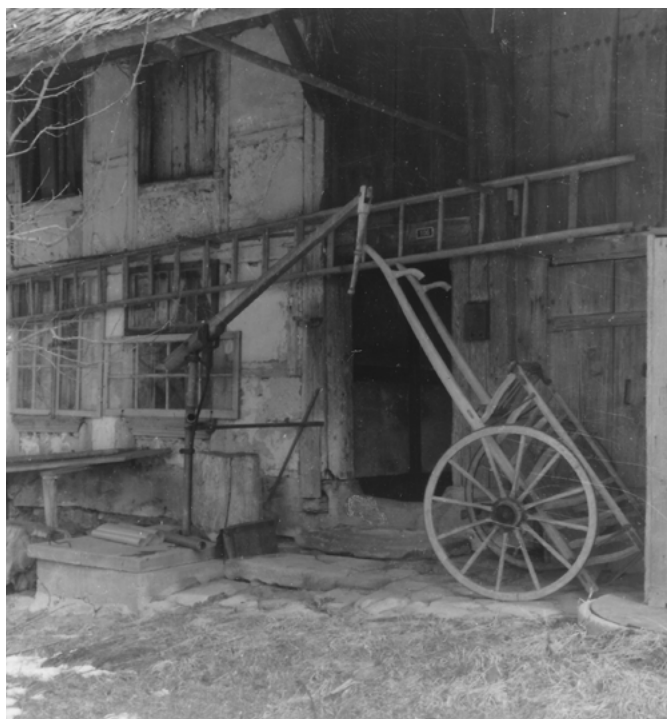
24 Detligen, Untere Schmiede: Südliche Trauf- und Hofseite des Taunerhauses mit dem Hauseingang und dem danebenliegenden Tenntor, vor dem ein Handkarren abgestellt ist. Gut zu sehen ist, dass der Wohnteil auf der Südseite nicht wie im Norden vorspringt, sondern zweigeschossig als nachträglich ausgefachter und geriegelter Ständerbau mit grossen Einzelfenstern errichtet ist. Vor der Stube ist der Schwengel der Handpumpe des dortigen Sodbrunnens zu erkennen. Blick nach Nordwesten. Aufnahme 1965.
