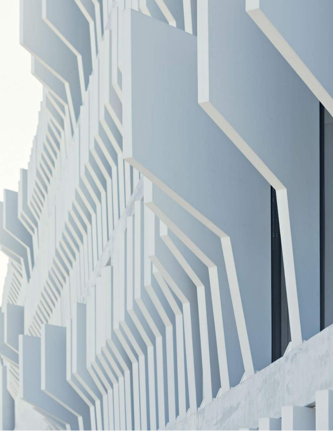
Estos elementos fijos de una planta de altura se han usado tanto en los edificios nuevos como en los existentes, unificando así lo «viejo» y lo «nuevo»
