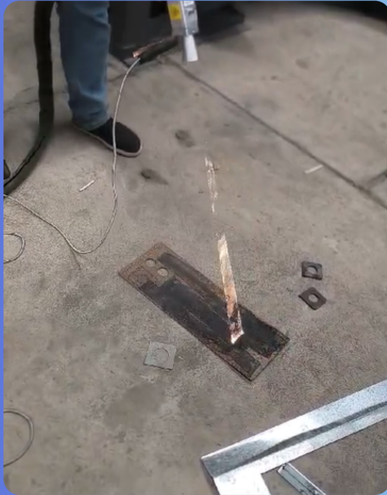
LIMPIEZA DE PLACA RETIRANDO EL OXIDO
