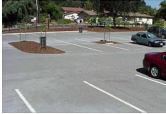
*Figura 3. Estacionamiento de hormigón permeable en Estados Unidos. (Imagen extraída de [www.perviouspavement.org](http://www.perviouspavement.org) / Sin copyright)*
