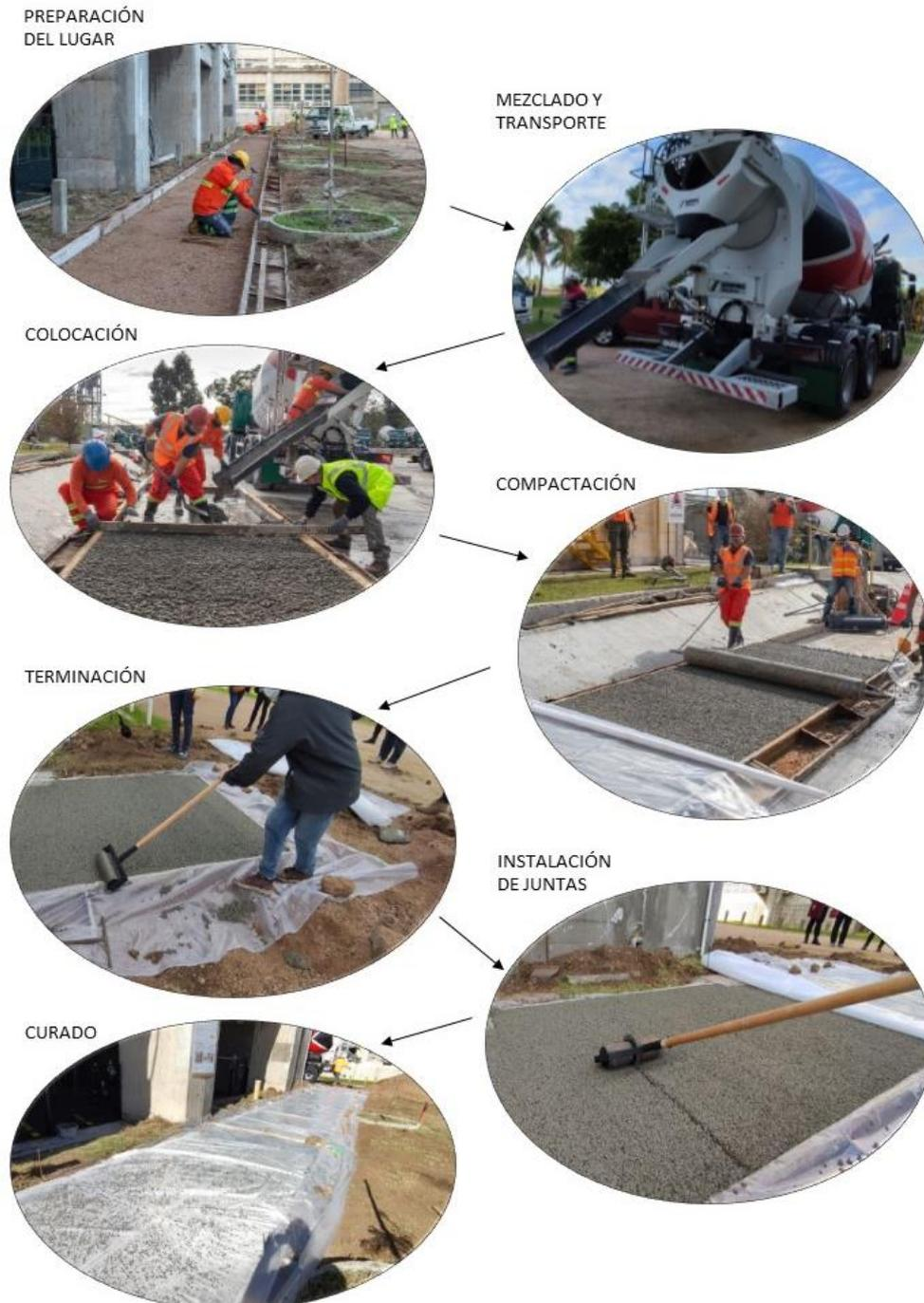
*Figura 20. Secuencia general de construcción de pavimentos de hormigón permeable.*
