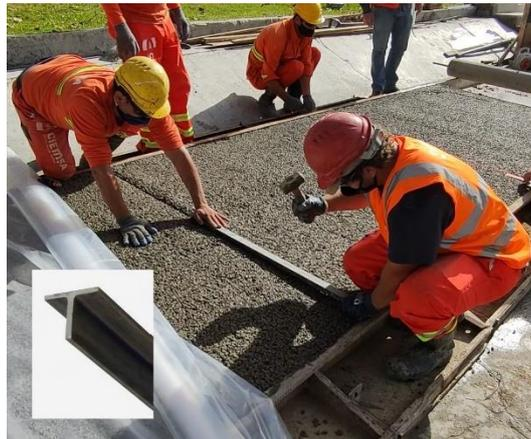
*Figura 30. Instalación de juntas mediante perfil te.*
