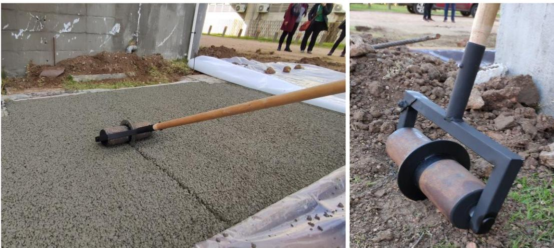
Figura 29. Rodillo “corta-pizza” para realización de juntas.
