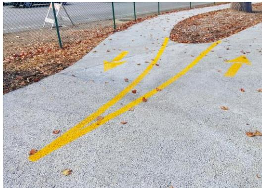
Figura 6. Bicisenda de hormigón permeable en California, Estados Unidos. (Imagen cortesía de: [www.bayareaperviousconcrete.com](http://www.bayareaperviousconcrete.com))
