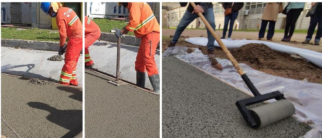
Figura 28. Ejemplo de reparación y compactación local mediante pisón y rodillo manual.
