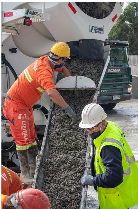
*Figura 22. Descarga de hormigón permeable desde mixer.*
