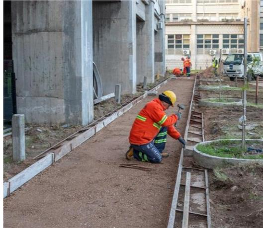
*Figura 21. Preparación del terreno previo a la colocación del hormigón permeable.*
