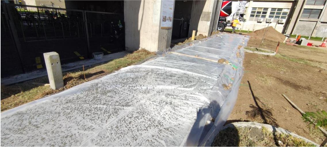
*Figura 31. Curado de hormigón permeable utilizando lámina plástica.*
