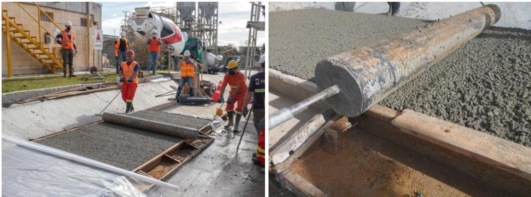
Figura 27. Ejemplo de compactación mediante “rodillo pesado” e imagen del rodillo.
