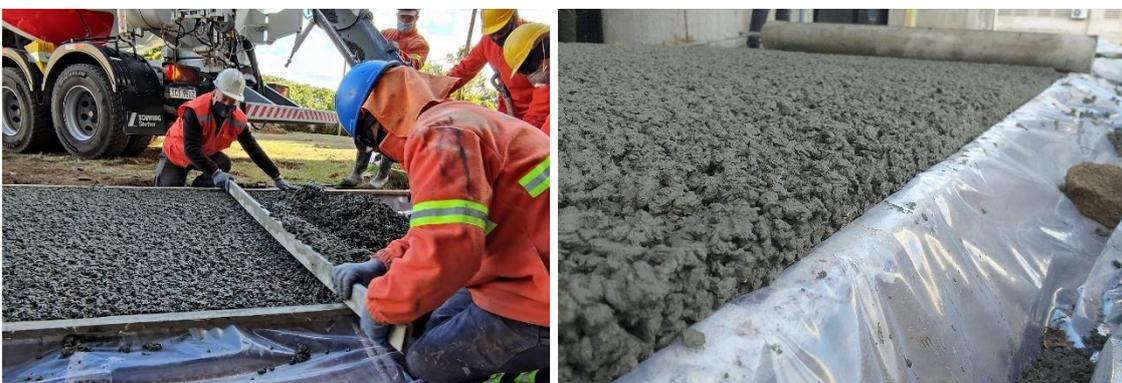
*Figura 26. Nivelación con sobrealtura y aspecto previo a la compactación luego de retirar listón.*
