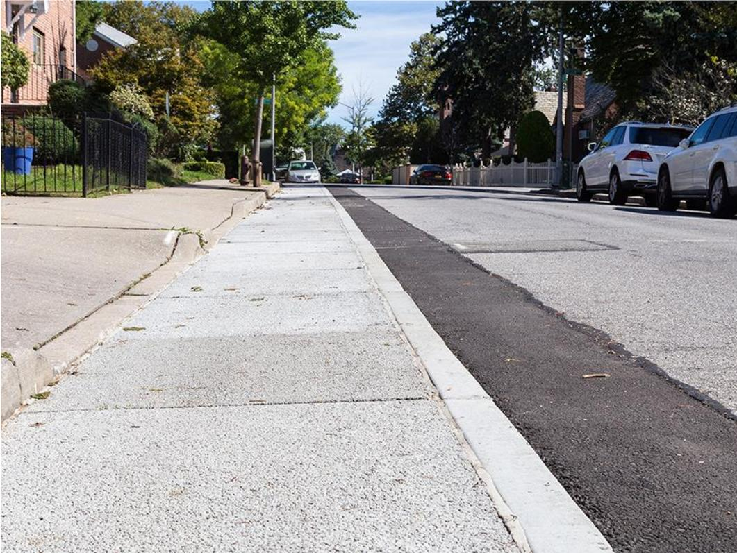
*Figura 7. Utilización de hormigón permeable a los laterales de una calle en Rego Park, Queens, Nueva York, Estados Unidos. (Imagen extraída de [www.nycstreetdesign.info](http://www.nycstreetdesign.info) / Sin copyright)*
