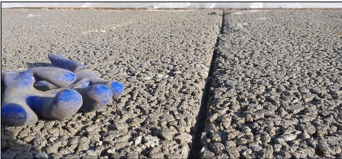
Figura 14. Superficie terminada de hormigón permeable.
