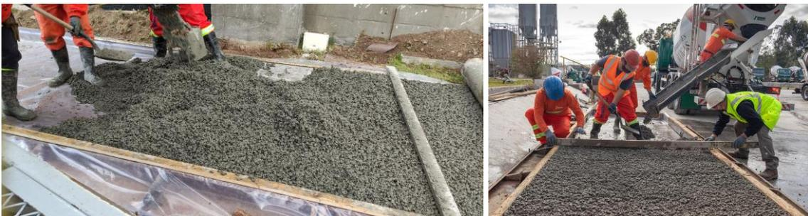
*Figura 25. Ejemplo de colocación y nivelación con regla manual.*
