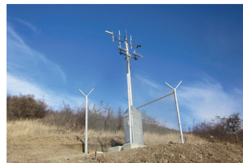
Мониторинг оползней с помощью удаленной камеры Republic of Georgia
