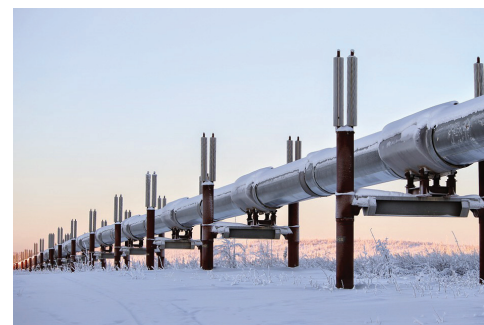
Катодная защита Trans-Alaska Трубопровод
