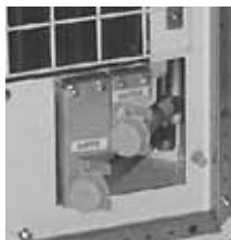
2 im oberen Bereich angeordnete Entlüftungsventile sorgen für die störungsfreie Funktion des Hydraulikregisters.
