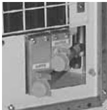
En partie supérieure, 2 purgeurs d'air permettent d'assurer le bon fonctionnement de la batterie hydraulique.
