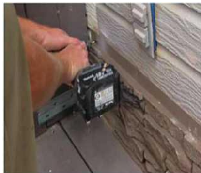
3. Install the first panel from the left bottom. 从墙底左侧开始安装第一块板
