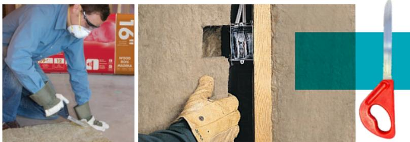
Se corta con rapidez y precisión con un cuchillo serrado, como los cuchillos de pan, de modo que puede lograr un ajuste óptimo fácilmente alrededor de tuberías, cajas de electricidad, cableado, ductos y entre los listones y vigas que tengan un ancho que no sea estándar.
