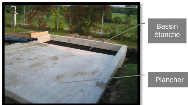
Figure 2.3 Aménagement comprenant un plancher et un bassin de rétention
