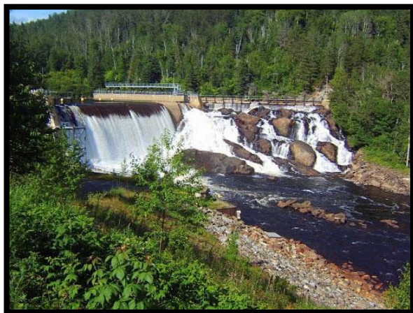
Figure 8.21 Barrage sur la rivière Malbaie, à Clermont
