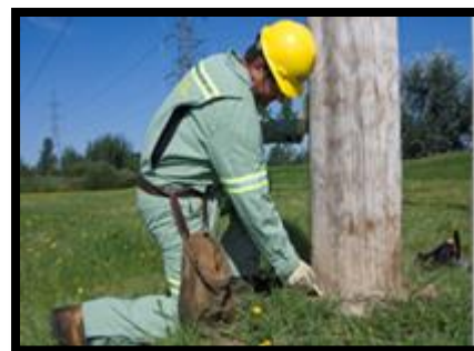
Figure 5.5 Application d'un pesticide à la base d'un poteau de bois
