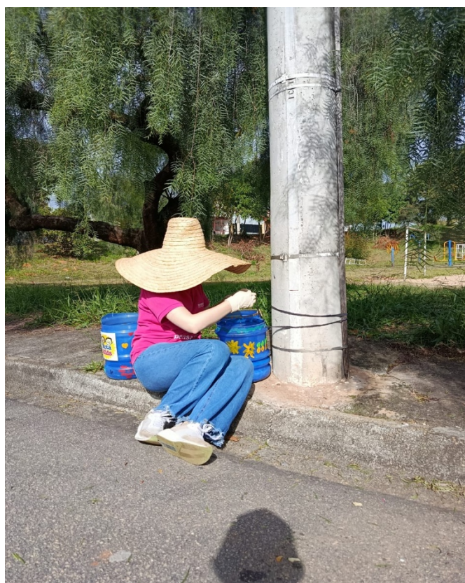
Figura 1 - Instalação das lixeiras
