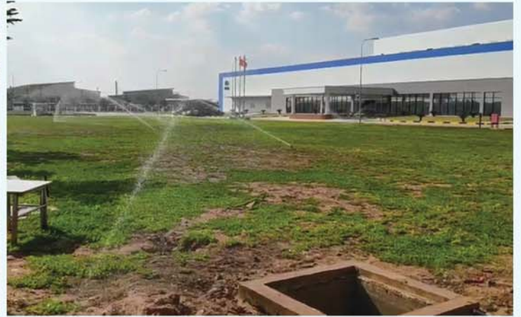
Hệ thống tưới – Nhà xưởng TATA-VSIP II, Bình Dương
