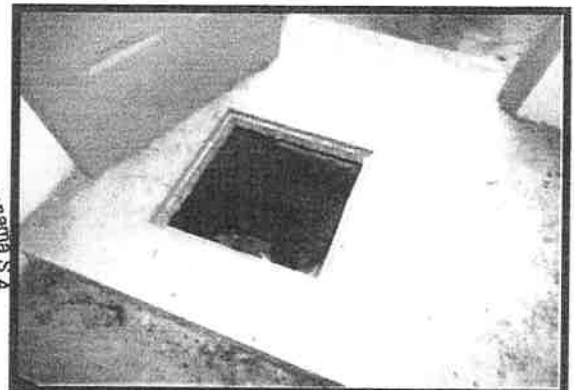
VISTA GENERAL DE UNA CAMARA DE INSPECCIÓN
