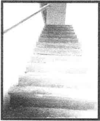
VISTA GENERAL DE LA ESCALERA
