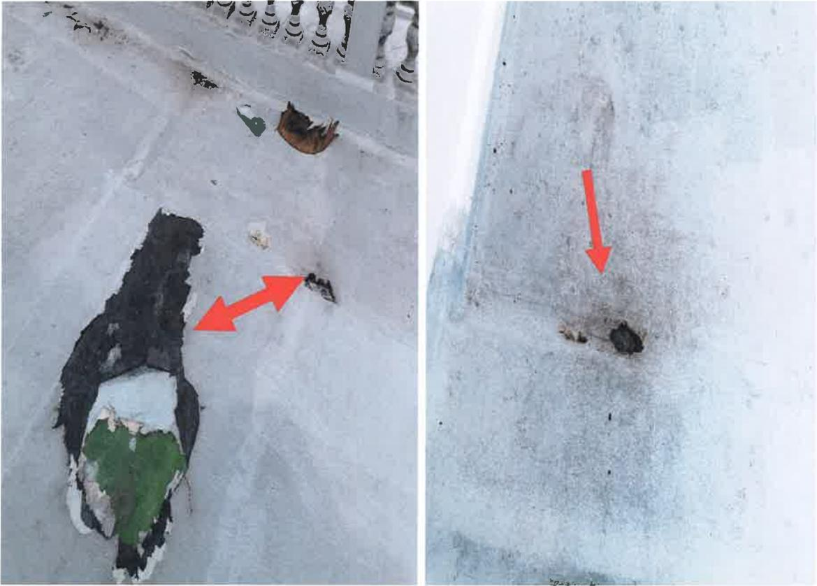
HAY PUNTOS EVIDENTES EN LA AZOTEA QUE AMERITAN REPARACIÓN DEL MANTO IMPERMEABILIZANTE. MUESTRA DETERIORO EN PUNTOS ESPECÍFICOS.
