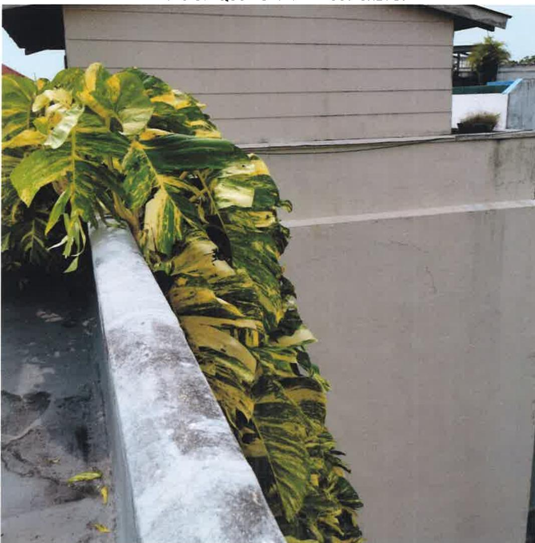
ESTA PLANTA TIENE SUS RAÍCES EN TIERRA, PERO IGUALMENTE REQUIERE SER REMOVIDA PORQUE SE HA FIJADO IGUALMENTE A SUS PAREDES. COMO TODA PLANTA, SUS RAÍCES PUEDEN ADHERIRSE PENETRANDO LAS FISURAS QUE SUPURAN HUMEDAD, PARA
