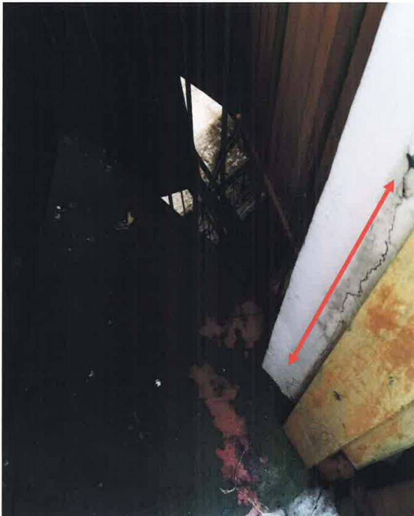
LAS FISURAS EN PAREDES EXTERNAS, CUANDO LLUEVE SOBRE TODO CON RÁFAGAS HUMEDECEN LAS PAREDES DE CALICANTO INTERIORMENTE LO CUAL SE MANIFIESTA EN MANCHAS DE HUMEDAD.
