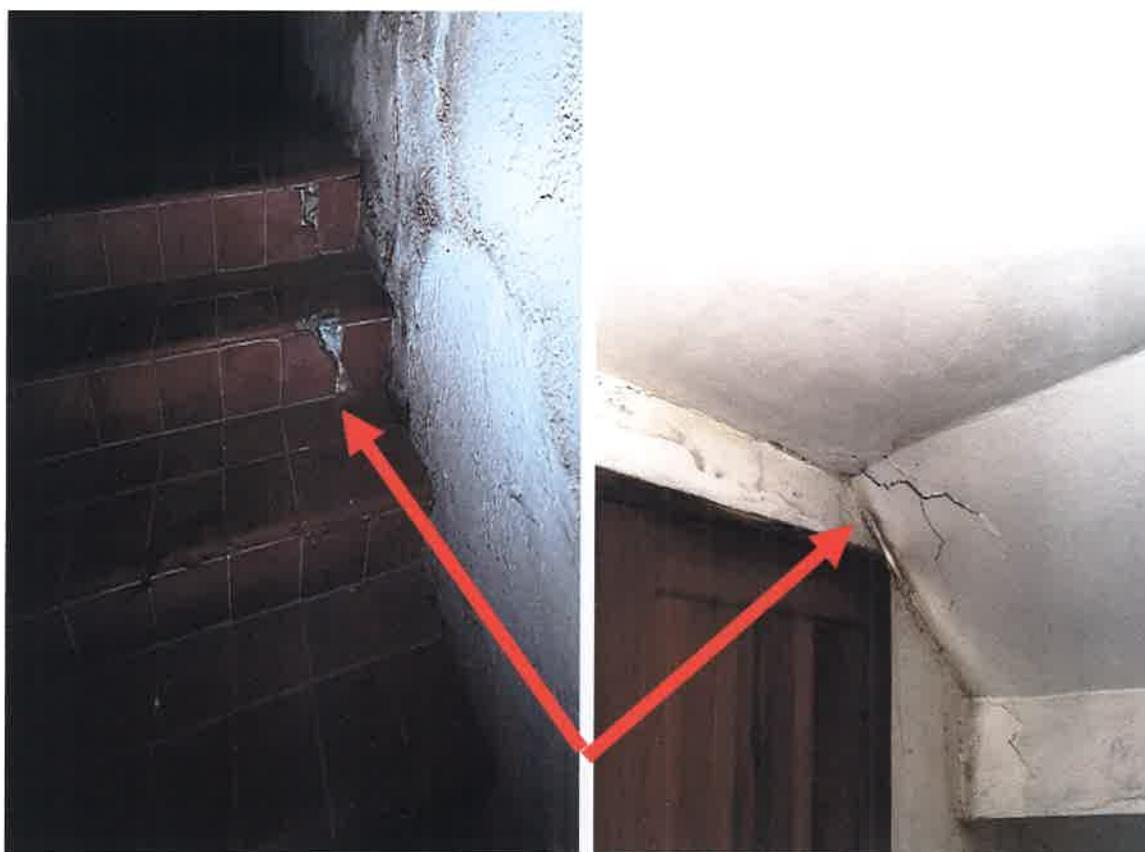
**AGRIETAMIENTO EN ESCALERA, VERIFICAR COLOCACIÓN DE ARMADURA Y REFORZAR DINTEL DE PUERTA. TRABAJOS DE MANTENIMIENTO.**
