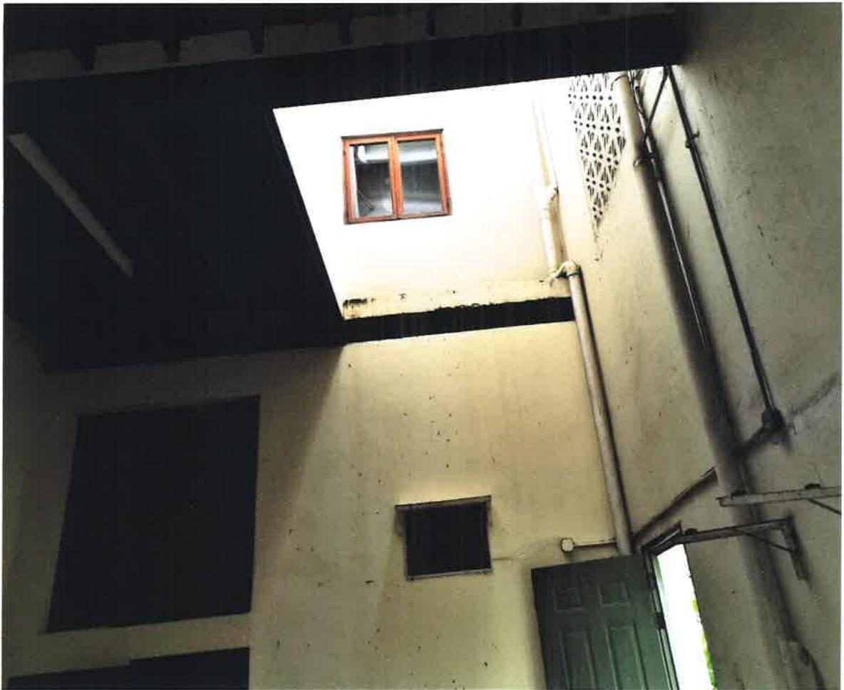
PARTE POSTERIOR DE LA ESTRUCTURA DENTRO DE LA FINCA 1250. CAÑÓN, GENERALMENTE OCUPADO POR EL PERSONAL DE SERVICIO DE LA CASA. COLECTORAS DE PVC, VIGAS DE ACERO, SISTEMA ELÉCTRICO ENTUBADO.
