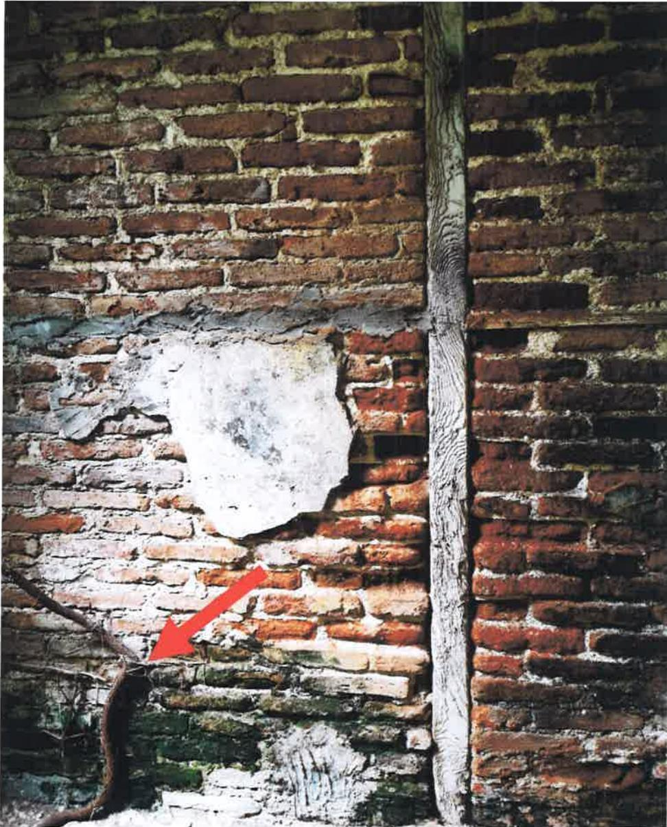
CUANDO APARECE CUALQUIER TIPO DE PLANTA O VEGETACIÓN SOBRE DIFERENTES ÁREAS DE LA CASA O EDIFICIO DEBERÁN ELIMINARSE INMEDIATAMENTE, DEBIDO A QUE CAUSAN FISURAS Y DISGREGACIÓN DE LOS MORTEROS DE JUNTAS Y A MEDIDA QUE LAS RAÍCES VAN CRECIENDO SE PROFUNDIZAN LAS FISURAS CONVIRTIÉNDOSE EN GRIETAS Y DESPRENDIMIENTO DE LOS REVOCOS (ARGAMASA).
