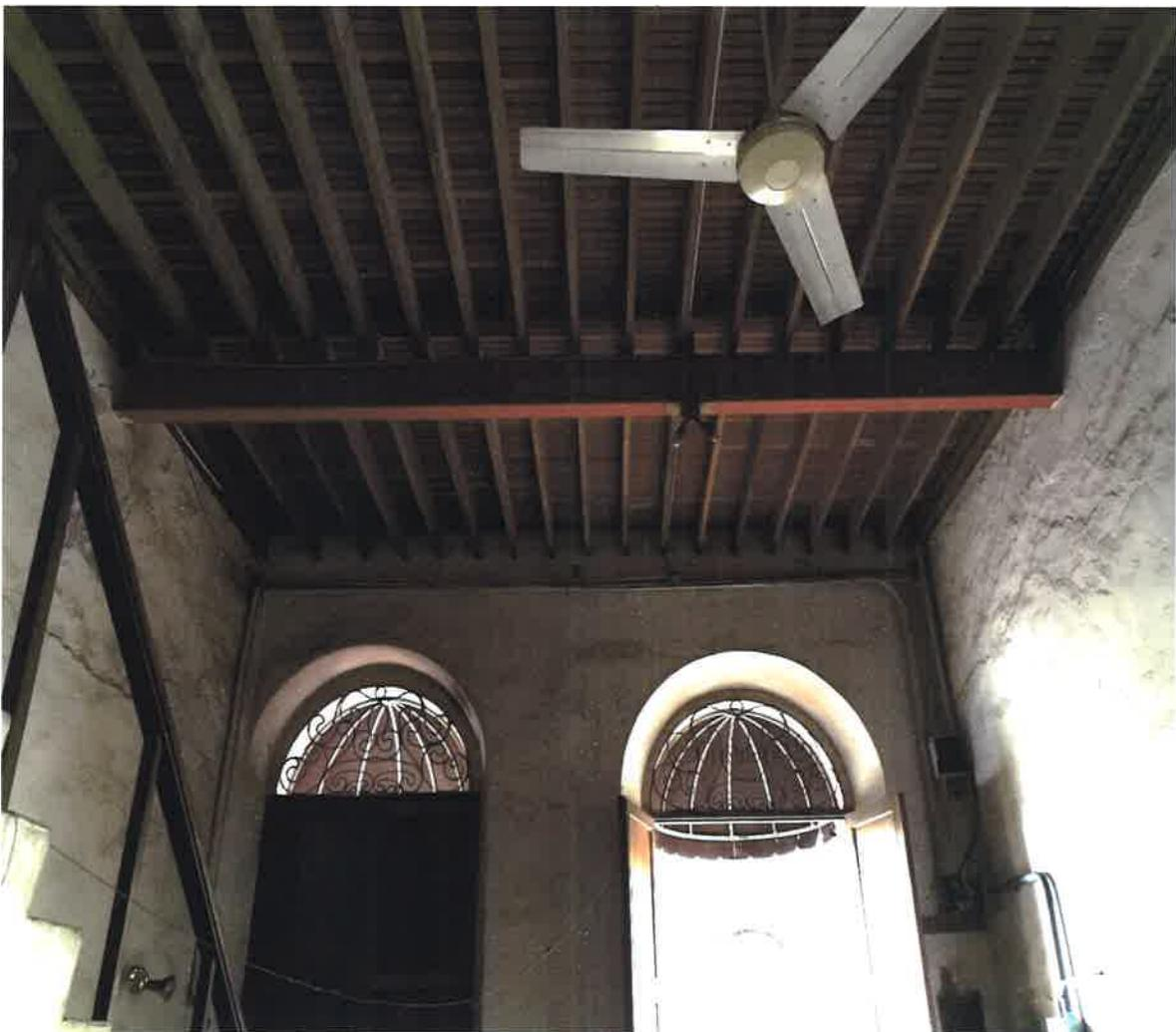
ENTRADA Y ACCESO A LA ESTRUCTURA DE LA 1250. ELEMENTOS DE ACERO COMO VIGA PRINCIPAL, ABANICO, SISTEMA ELÉCTRICO. SIN EMBARGO, TAMBIÉN SE MANTIENEN ELEMENTOS ARQUITECTÓNICOS Y MATERIALES DE LA REMODELACIÓN (VIGAS DE ACERO, ENTUBADO ELÉCTRICO, CAJAS Y ACCESORIOS).
