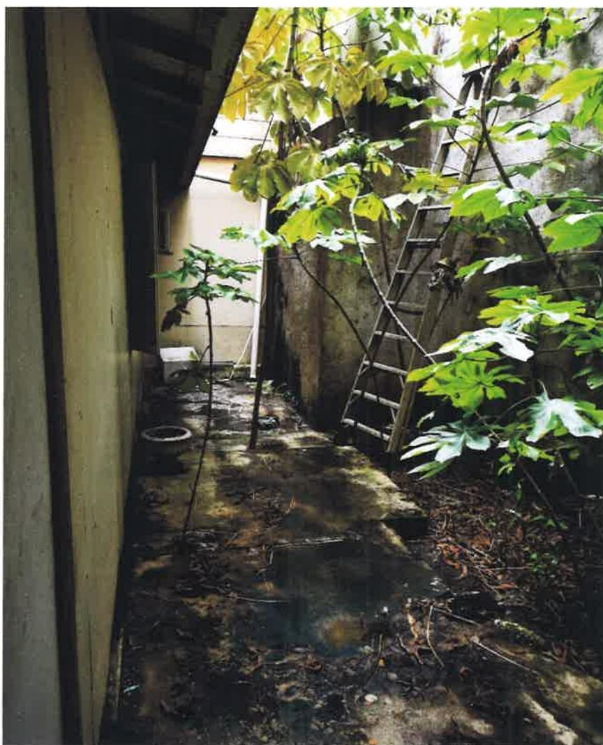
PATIO POSTERIOR DE LA FINCA 3310. SE APRECIAN LAS PAREDES DE CALICANTO REVESTIDAS DE MORTERO DE CEMENTO Y ARENA.
