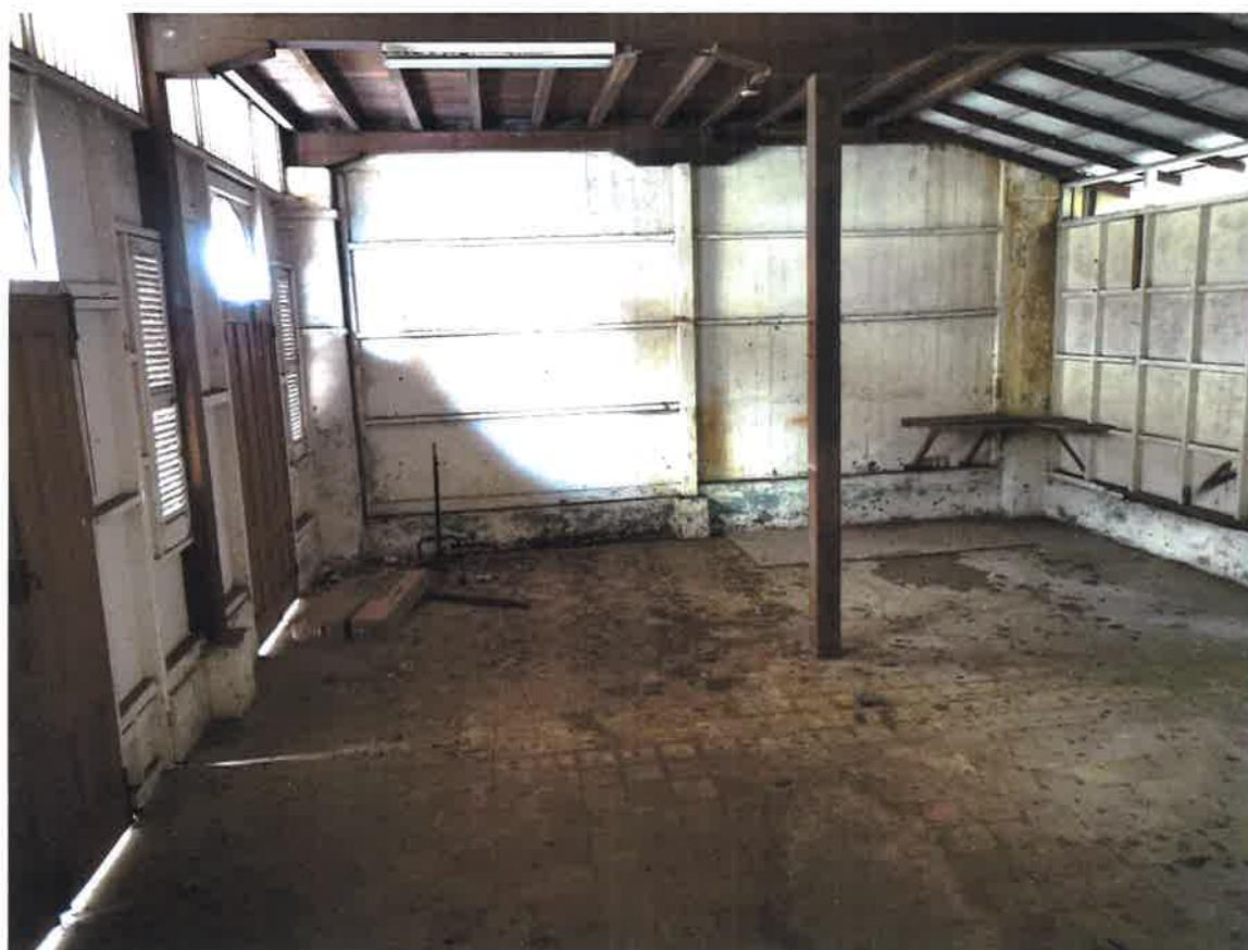
LA ESQUINA DERECHA DE LA PARED INTERIOR DEMUESTRA TRANSMISIÓN DE LA HUMEDAD HACIA EL REPELLO QUE CUBRE LA COMPOSICIÓN DE CALICANTO DE LA MISMA. EL REPELLO EN ESTE TIPO DE COMPOSICIÓN IMPIDE QUE LA PARED TRANSPIRE, DEBIDO A SU COMPOSICIÓN FÍSICA DE PIEDRA QUE ABSORBE DE LA HUMEDAD RELATIVA DEL AMBIENTE, INFILTRACIONES, ENTRE OTRAS.
