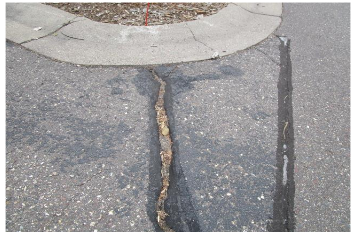
Old crack fill
