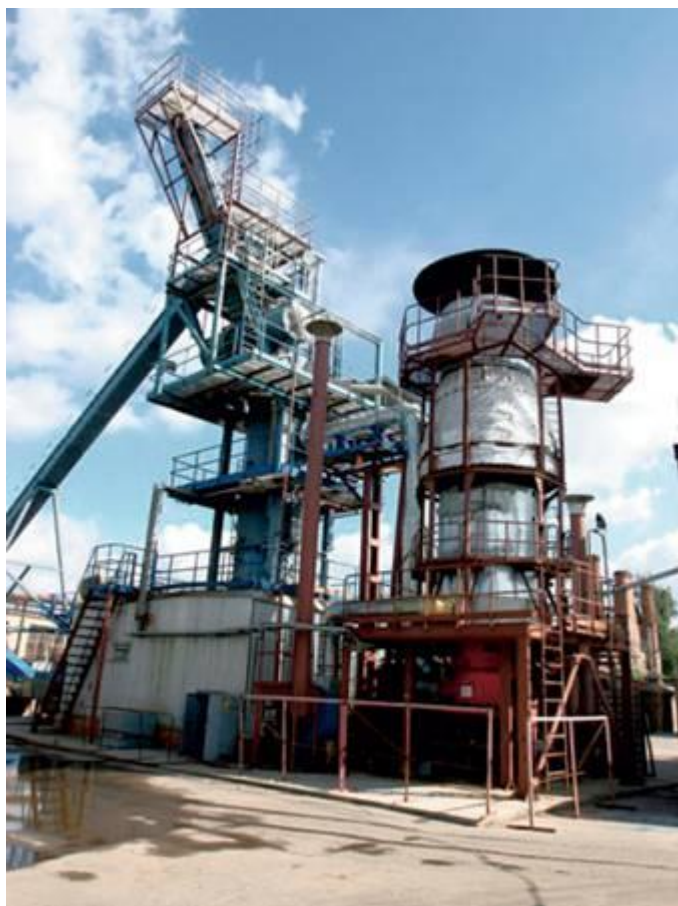
Комплекс паровоздушной газификации, разработанный ФГУП «Салют» и ОАО «НИИхиммаш»
