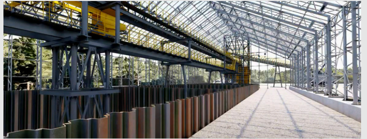
ベルトコンベア・防音ハウス・地下ピット
