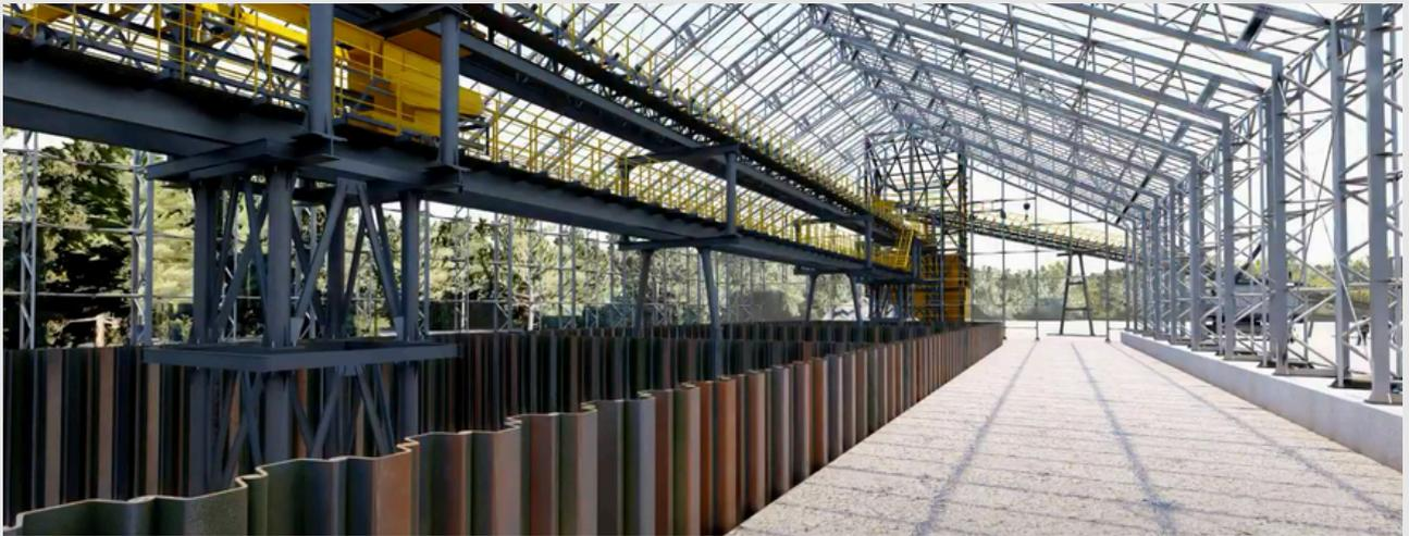
ベルトコンベア設計・防音ハウス・地下ピット
