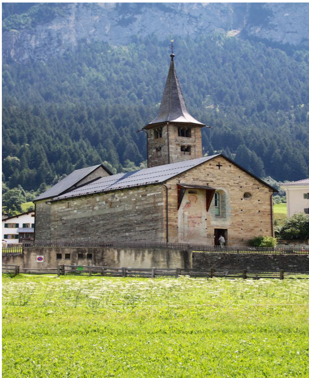
Figura 1: Fotografia da parte lateral e frontal da Igreja de São Martinho de Zillis.
