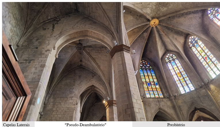
Figura 8 – Divisão interna da Basílica de Santa Maria, apesar de visualmente serem três espaços distintos, somente duas abóbodas formam a cobertura, criando uma solução híbrida. Fonte: autora.
