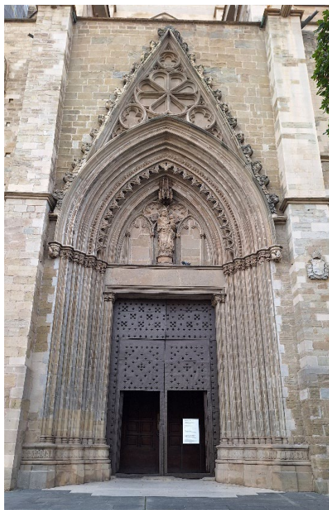
Figura 10 – Portal lateral de Santa Maria na fachada noroeste da basílica. Tradicionalmente, essa é a entrada principal do templo devido sua localização.
