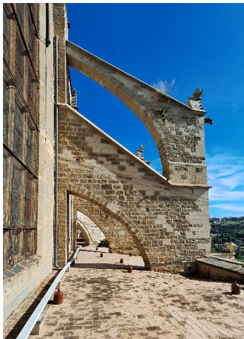
Figura 7 – Duplo arcobotantes exteriores de Santa Maria. Fonte: autora.
