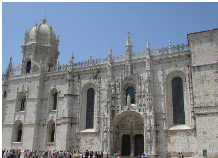
Figura 5: Portal Lateral da Igreja do Mosteiro de Santa Maria de Belém.
