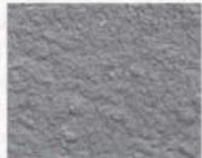
CSP 5 (medium-heavy shotblast)
