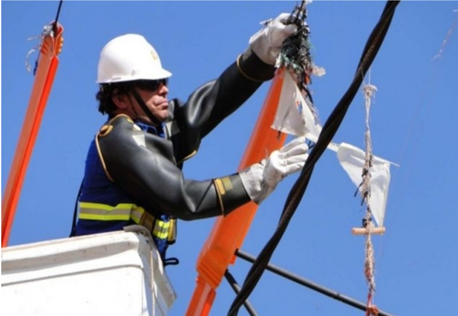
Trabalho ao Contato 13,8 KV
