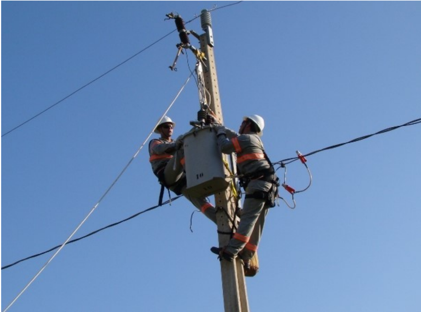
Serviços de manutenção em transformador de Distribuição
