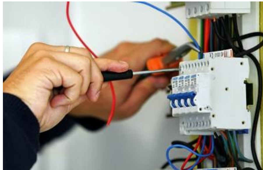
Intervenção em instalação elétrica
