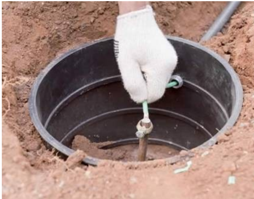
Conexão do cabo
