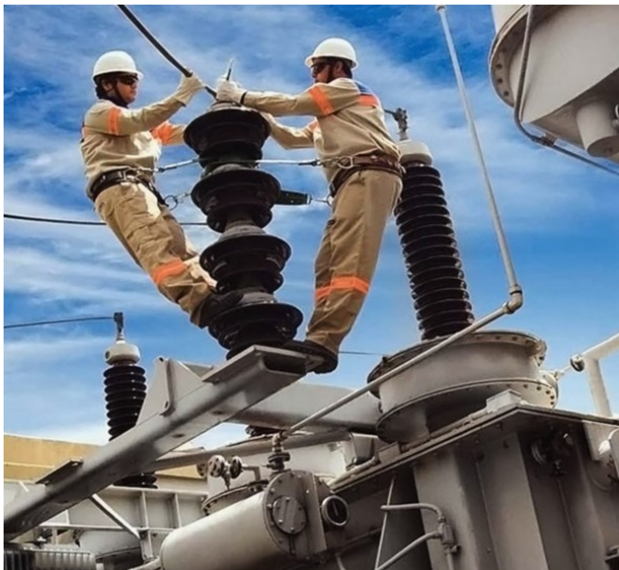
Serviços de manutenção em transformador de Subestação
