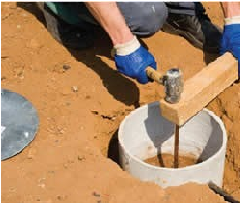
Instalação da haste
