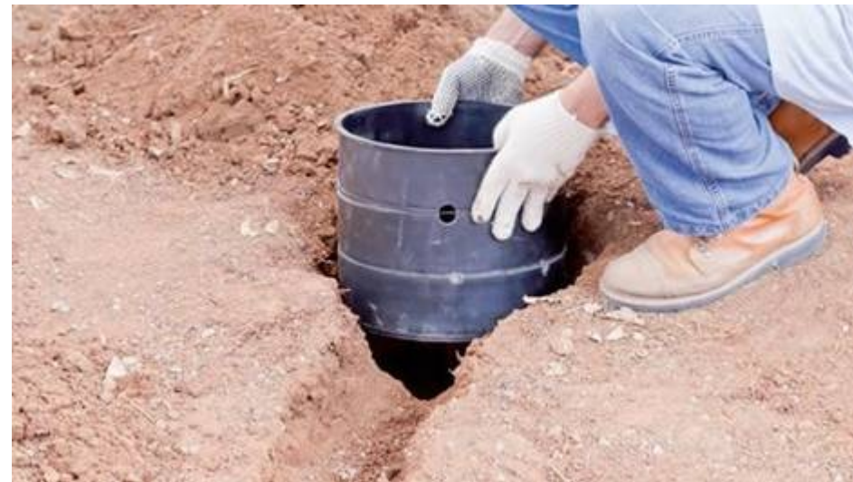
Instalação de caixa de inspeção
