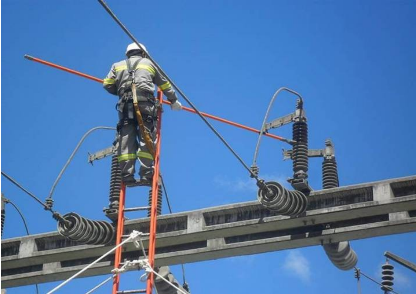
Trabalho à Distância 138 KV
