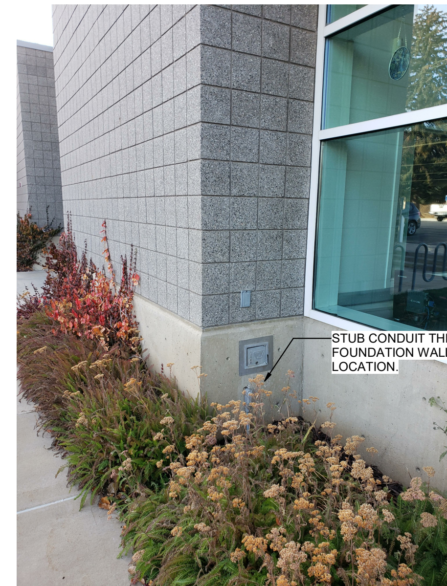
2 PHOTO 1 - CONDUIT ENTRY SCALE: NTS
