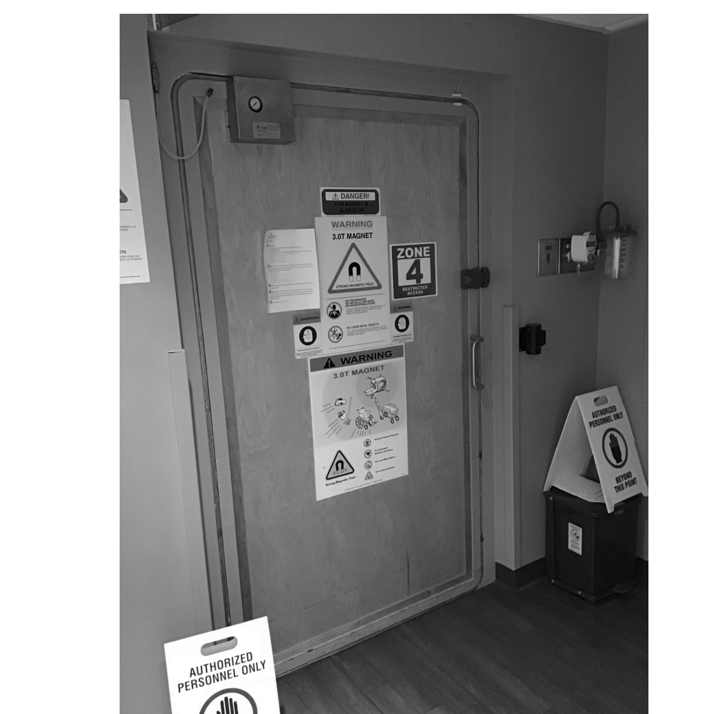
EXISTING MRI ROOM DOOR
