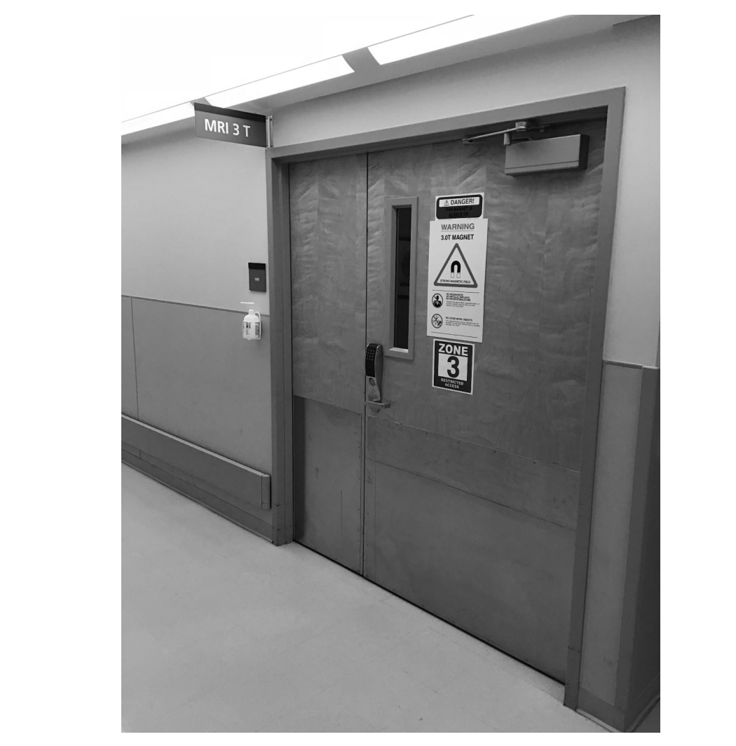
EXISTING MRI SUITE / CONTROL ROOM DOOR
