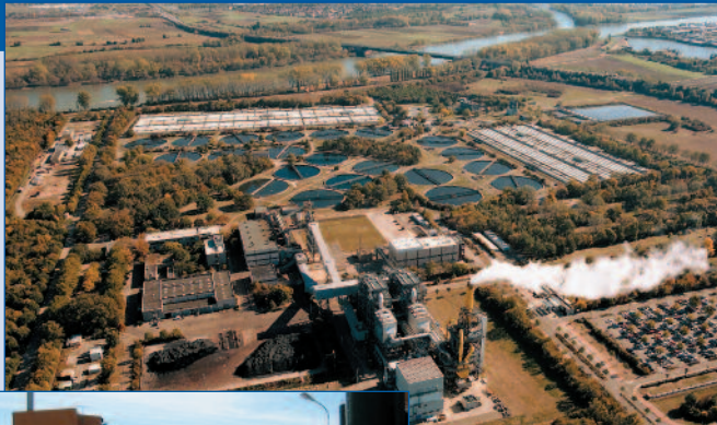
STP BASF Ludwigshafen
