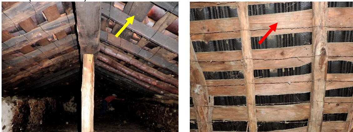
Fotos 5 y 6. Chillas en la cubierta de un sequero y de otro tipo de edificio rural 18
