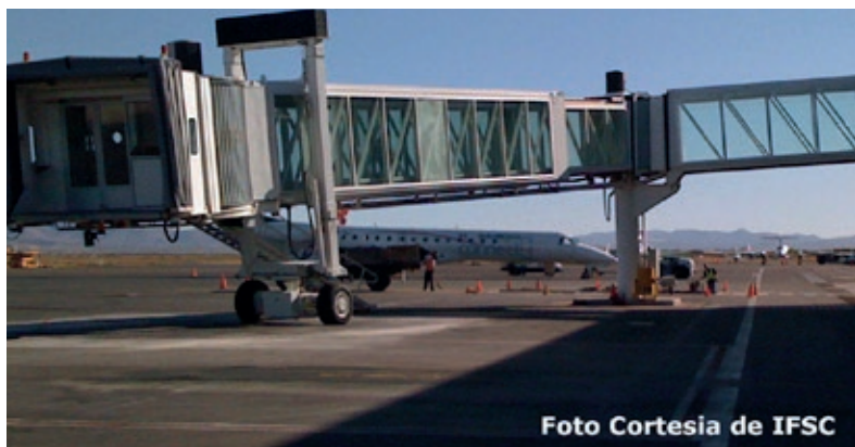
PUENTE DE DESEMBARQUE DE CRISTAL SIN PROTECCIÓN CONTRA INCENDIOS
