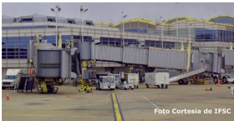
PUENTE DE DESEMBARQUE CON ESTRUCTURA PROTEGIDA CONTRA INCENDIOS
