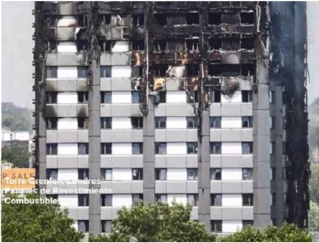
Foto de la fachada sur de la Torre Grenfell luego del incendio donde se aprecian los paneles MCM en el exterior.
