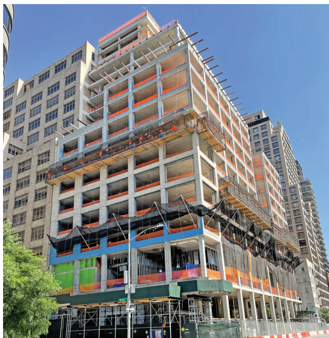
Los métodos de construcción y su resistencia al fuego en edificios de gran altura son muy similares a nivel mundial.
